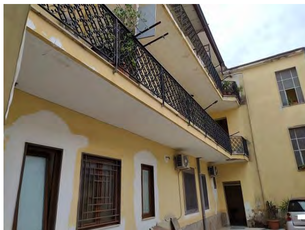
Vista dal cortile interno del fabbricato
