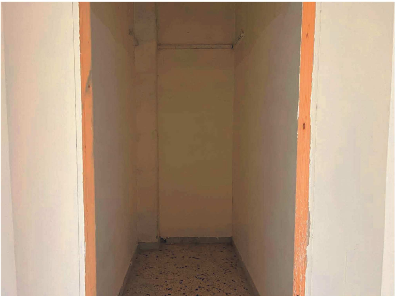
Foto 9 – Vista del ripostiglio
