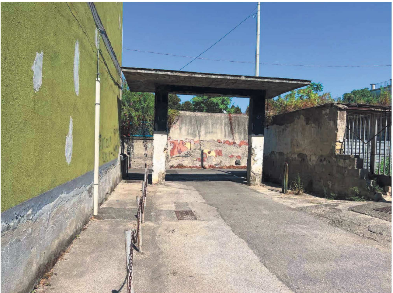
Foto 2 – Dettaglio del varco carrabile che immette nell'area cortilizia del complesso di via Luigi Martucci n. 50, Napoli
