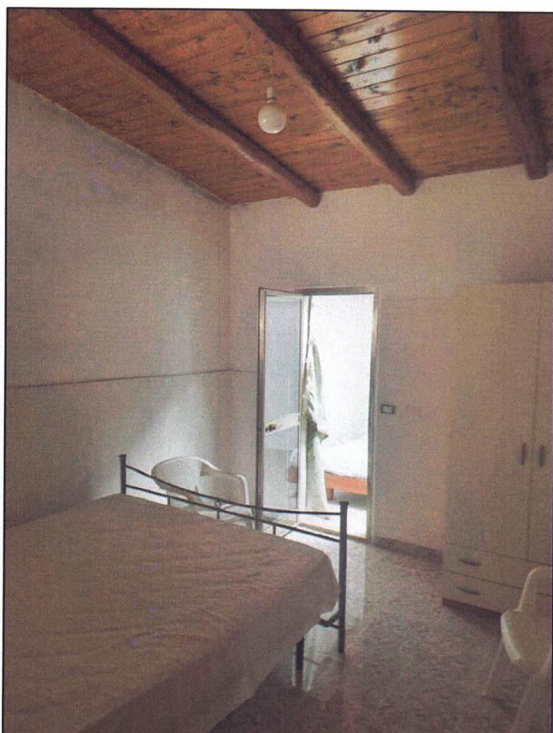
Foto 9-10 - Foto della camera 1 e 2 della UI1, coperte con tetto a falde in legno. Entrambi gli ambienti sono pavimentati in ceramica, dotati di infissi in acciaio. In particolare la camera 2 è da demolire in quanto rappresenta un volume aggiunto non sanabile (L. 47/85).
