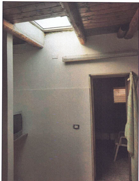
Foto 9-10 - Foto della camera 1 e 2 della UI1, coperte con tetto a falde in legno. Entrambi gli ambienti sono pavimentati in ceramica, dotati di infissi in acciaio. In particolare la camera 2 è da demolire in quanto rappresenta un volume aggiunto non sanabile (L. 47/85).
