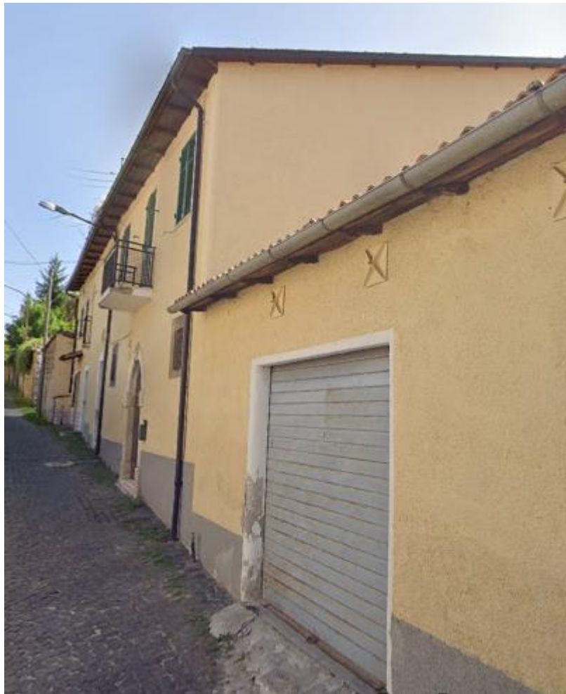
Figura 4 - Vista esterna dell'immobile
