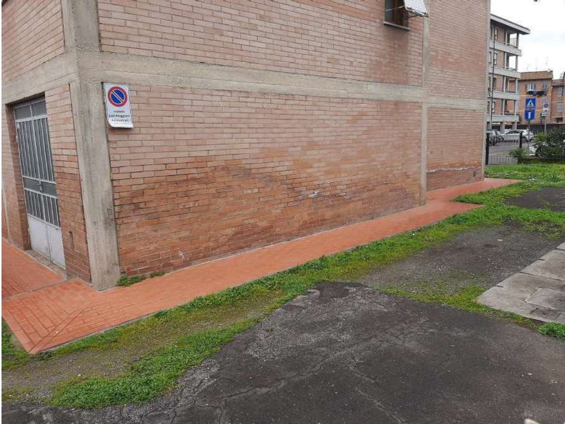
4 – Particolare dell'esterno della autorimessa
