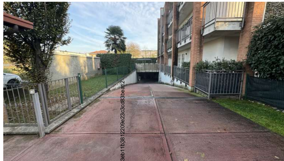
RAMPA DI ACCESSO AUTORIMESSA
