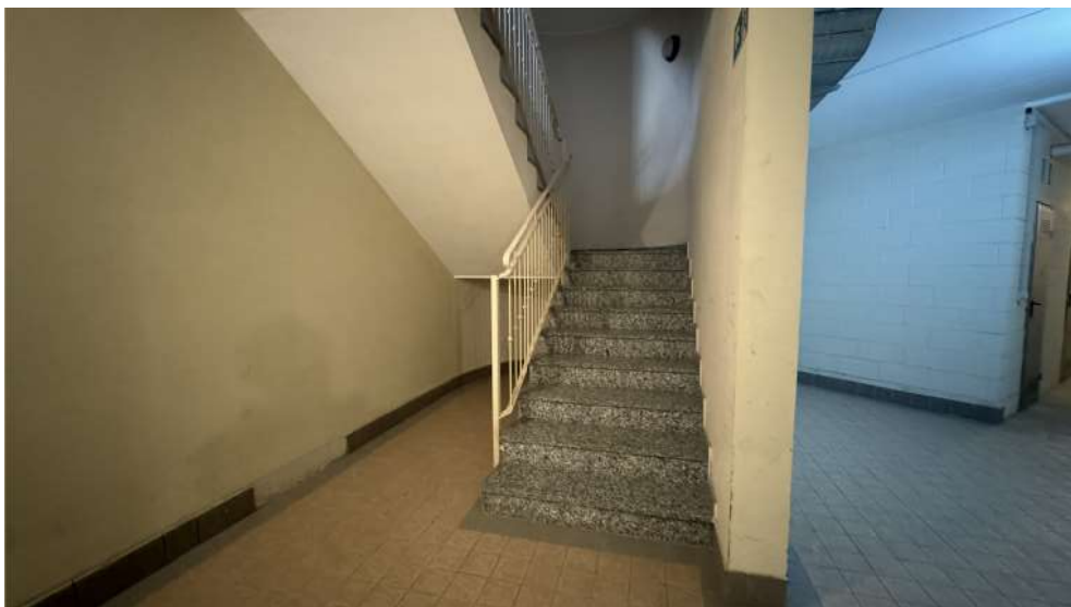
VANO SCALA PIANO INTERRATO
