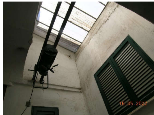
Foto 6 - Chiostrina coperta del vano scala
