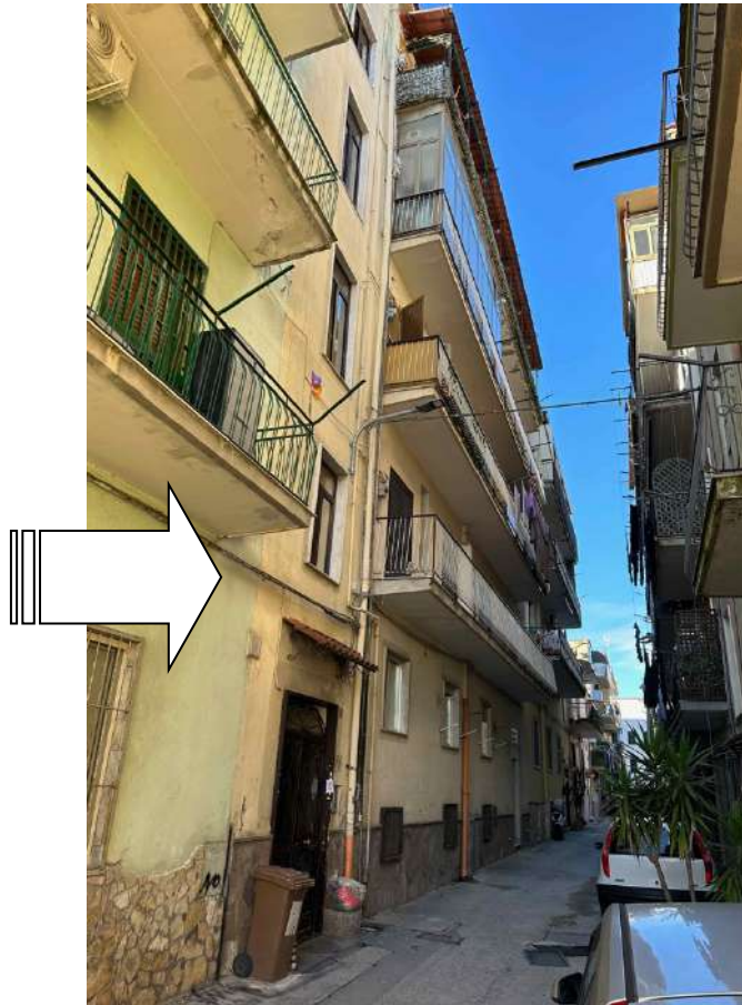
Foto 2 – Scorcio del fabbricato
