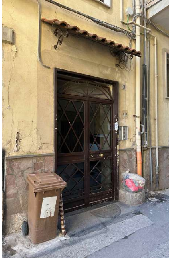
Foto 1 – Portone del fabbricato su Via Caserta
