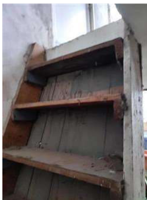
Particolare scala d'accesso al piano primo
