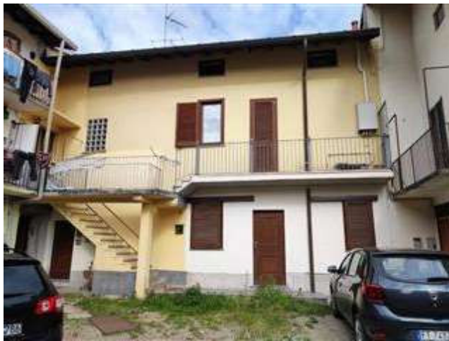
Prospetto sulla corte fabbricato residenziale
