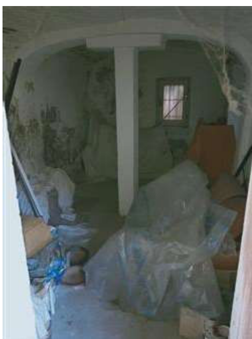
Ripostiglio al Piano Terra
