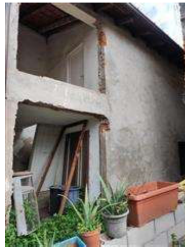
Prospetto fabbricato accessorio pertinenziale
