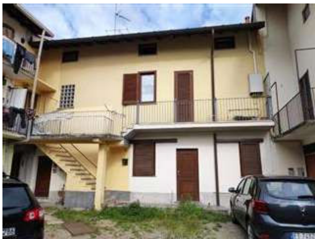
Prospetto sulla corte fabbricato residenziale
