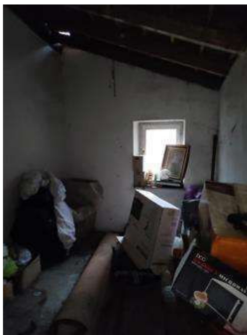
Ripostiglio al Piano Primo
