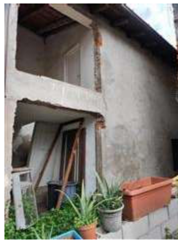
Prospetto fabbricato accessorio pertinenziale
