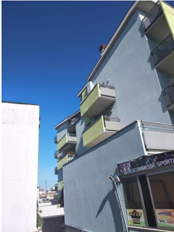
FOTO 1: VISTA PROSPETTO SUD OVEST CONDOMINIO OLIMPIA RESIDENCE
