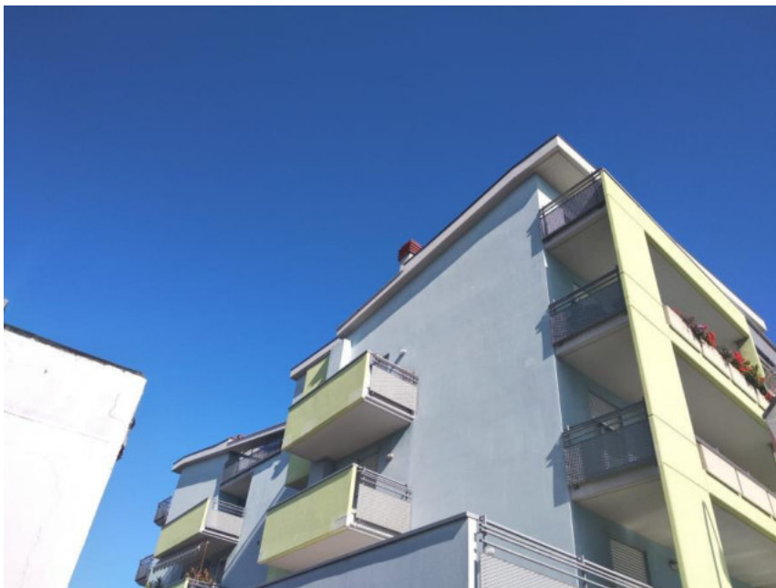
FOTO 2: VISTA PROSPETTO SUD OVEST CONDOMINIO OLIMPIA RESIDENCE
