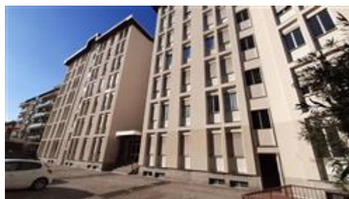
Vista dello stabile condominiale dal cortile comune/condominiale
