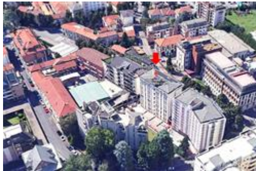
Vista aerea con localizzazione / identificazione della palazzina cui appartengono le uu.ii. oggetto di stima - FRONTE NORD
