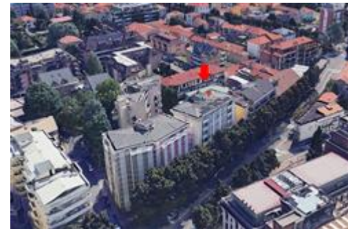
Vista aerea con localizzazione / identificazione della palazzina cui appartengono le uu.ii. oggetto di stima - FRONTE OVEST
