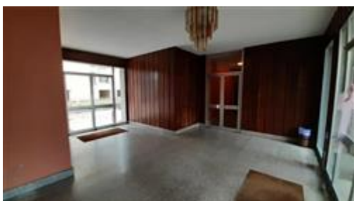
Vista dell'atrio di ingresso alla palazzina
