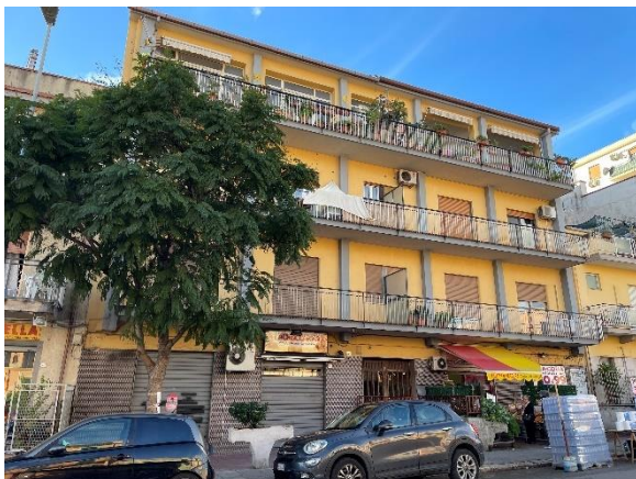
Prospetto dell'edificio su via Pitrè
