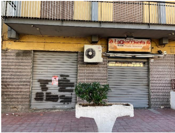
Accesso all'immobile (in catasto via Pitre, 102/A)
