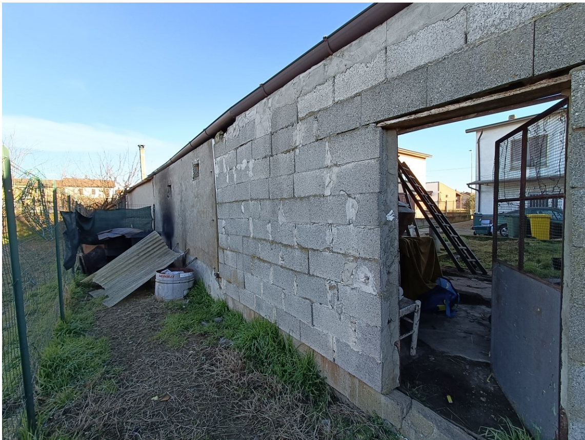
Retro autorimessa e locali accessori
