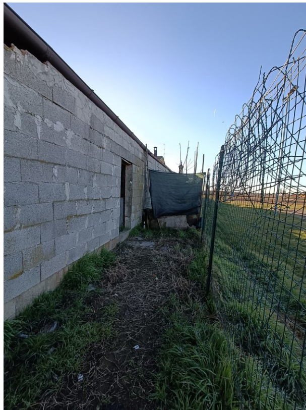
Retro autorimessa e locali accessori
