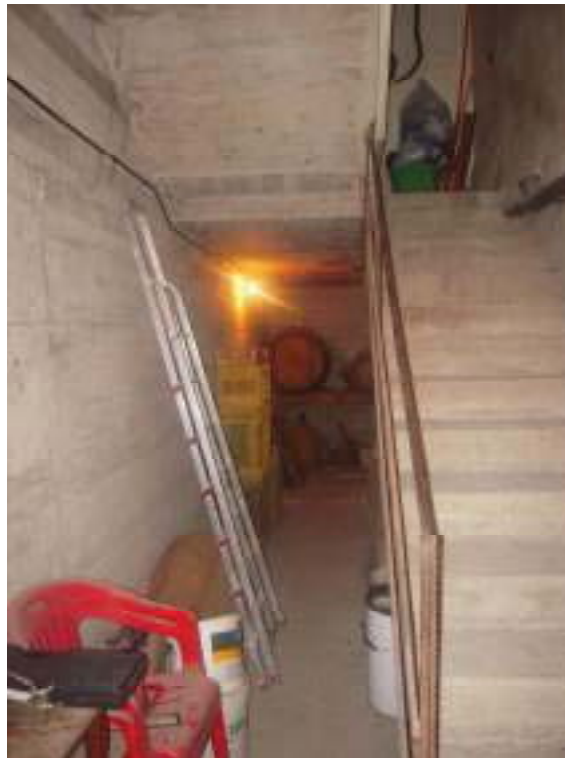
Foto n°24 – Rampa scala cantina al piano seminterrato
