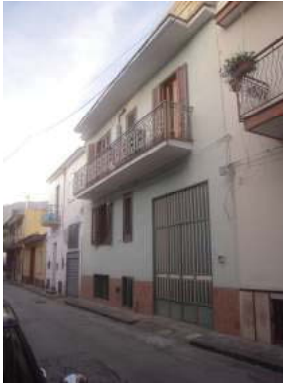
Foto n°1 – Prospetto principale su via SA Apostoli
