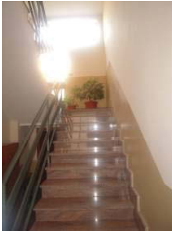
Foto n°10 – Rampa scala piano rialzato piano primo
