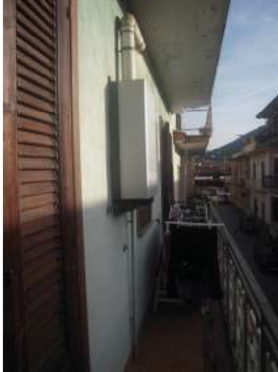
Foto n°21 – Balcone Piano Primo (LOTTO 2)
