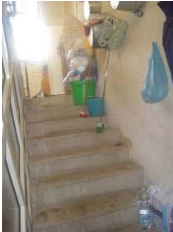
Foto n°22 – Rampa scala piano primo lastrico solare
