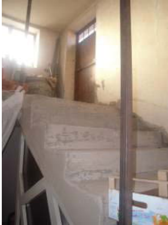
Foto n°23 – Rampa scala piano primo lastrico solare
