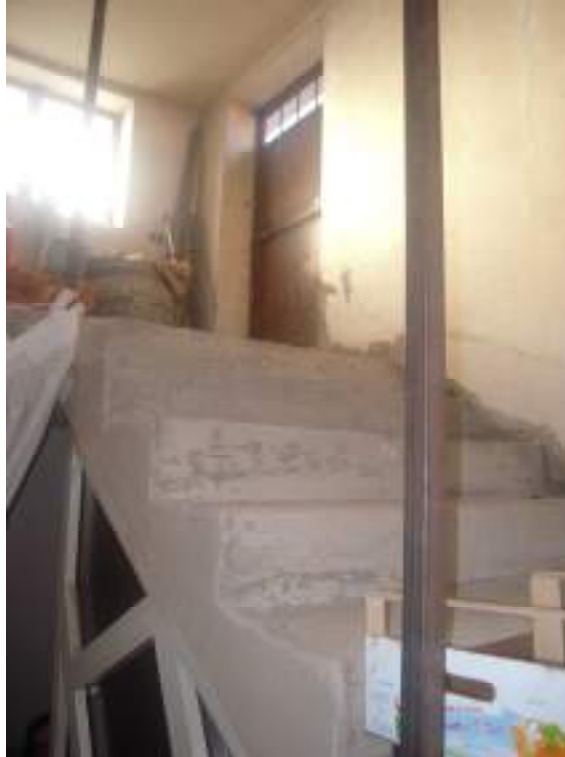
Foto n°23 – Rampa scala piano primo lastrico solare
