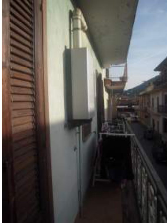
Foto n°21 – Balcone Piano Primo (LOTTO 2)
