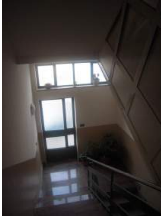
Foto n°13 – Accesso secondario corte
