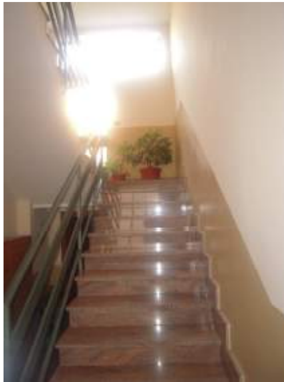
Foto n°10 – Rampa scala piano rialzato piano primo
