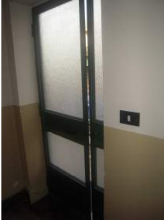
Foto n°11 – Accesso secondario corte
