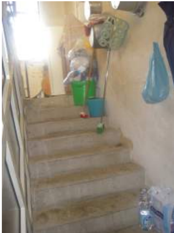
Foto n°22 – Rampa scala piano primo lastrico solare
