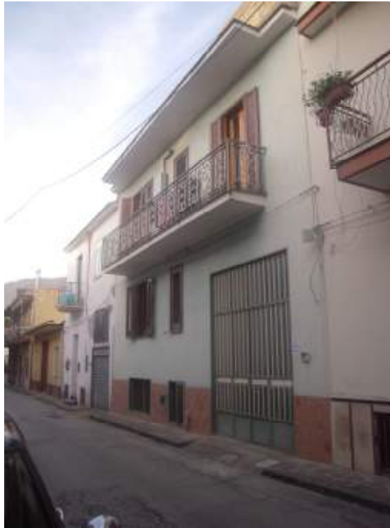
Foto n°1 – Prospetto principale su via [REDACTED]
