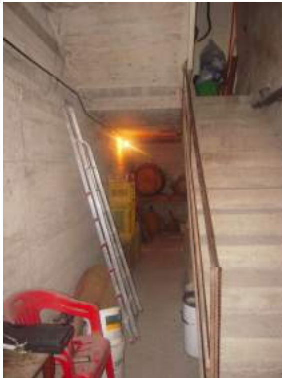
Foto n°24 – Rampa scala cantina al piano seminterrato
