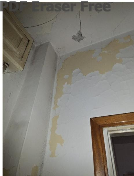
L'unità immobiliare in oggetto si presenta in cattivo stato di manutenzione interna, con pareti e soffitti con tinteggiatura che sfoglia e si stacca, caloriferi arrugginiti sulla superficie ed impianti non conformi.
