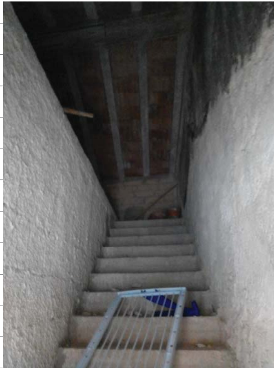
FT7/8 – WC AL PIANO – SCALA AL SOTTOTETTO
