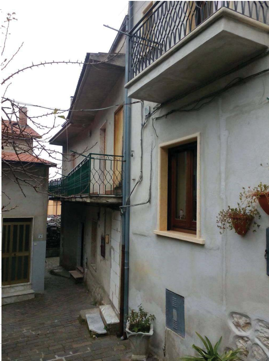
FT1 - FRONTE PRINCIPALE DELL'IMMOBILE (FABBRICATO1 - FG24 - 346/1)
