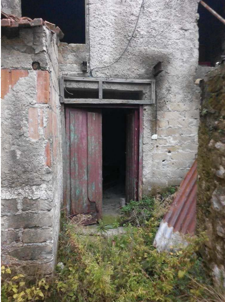
FT8 – Volume rudere Piano sottano e soprano (sottotetto).
