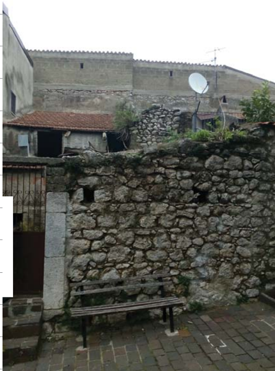
FT9/10 – muro recinto sulla strada e cassoni
