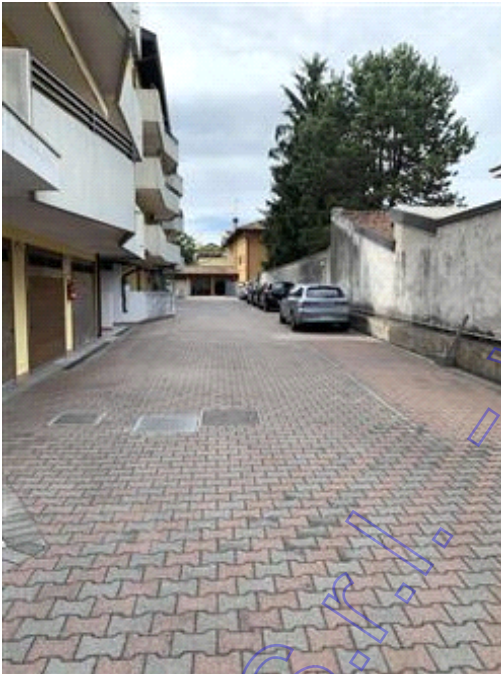
Area scoperta lato ovest con i posti auto.
