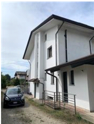
Fabbricato facciata ad est.
