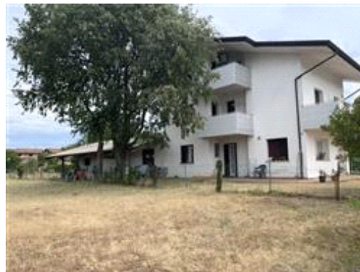
Fabbricato facciata ad ovest.
