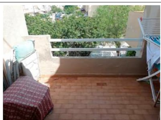
Foto 45. Vista dell'interno del balcone posto a Nord, al piano primo
