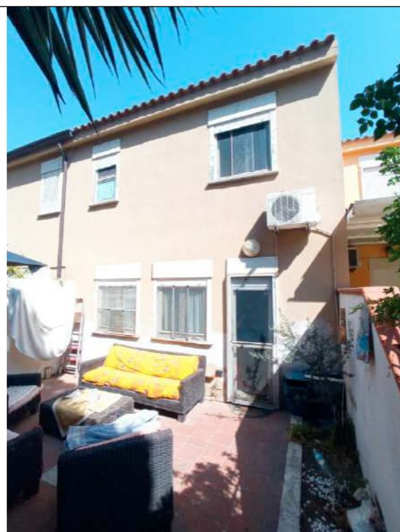
Foto 4. Vista esterna del fabbricato, prospetto retrostante Sud
