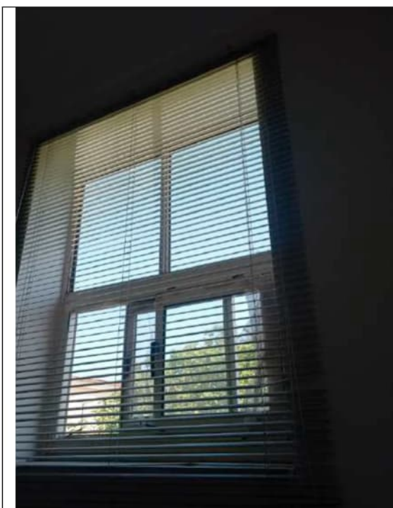
Foto 40. Particolare della tipologia di finestra interna con anta fissa, nella parte superiore, ed a due ante scorrevoli, nella parte bassa, in alluminio, vetro doppio, senza avvolgibili, posta nella scala che serve i due livelli dell'abitazione
