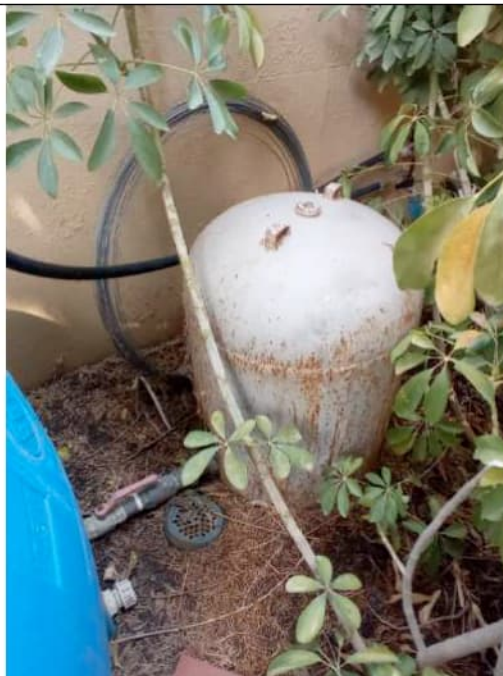
Foto 18. Particolare del motore dell'impianto autoclave
