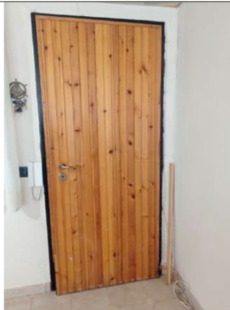
Foto 8. Particolare del portone di accesso all'immobile, di tipo blindato
