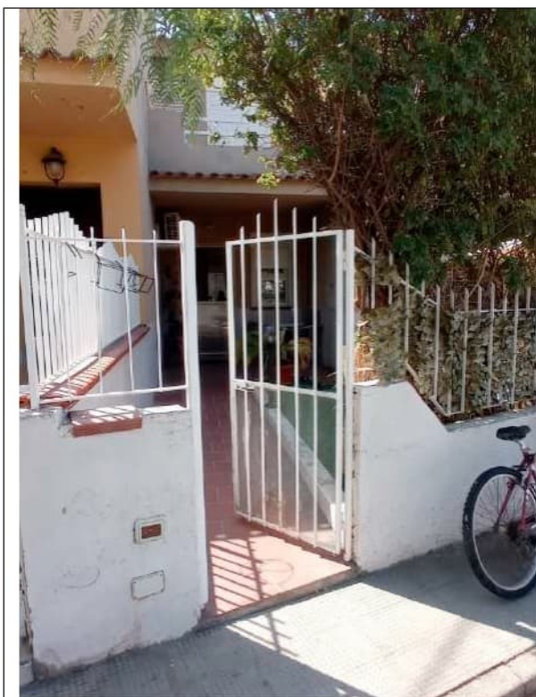
Foto 24. Particolare del cancelletto di accesso all'immobile
