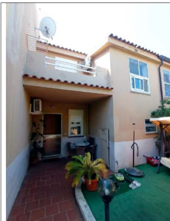
Foto 3. Vista esterna del fabbricato, prospetto principale Nord
