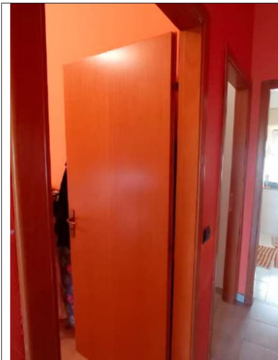
Foto 34. Particolare della tipologia di porta interna, in legno tamburato
