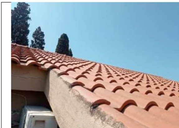
Foto 5. Vista esterna del fabbricato dove si osserva la tipologia costruttiva del tetto a falde inclinate con tegole in cotto
