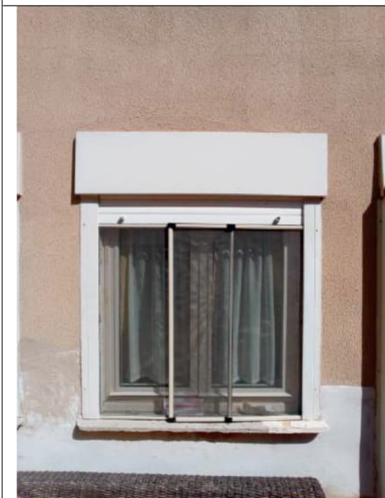
Foto 36. Particolare della tipologia di finestra esterna a due ante, in alluminio, vetro doppio, con avvolgibili in pvc
