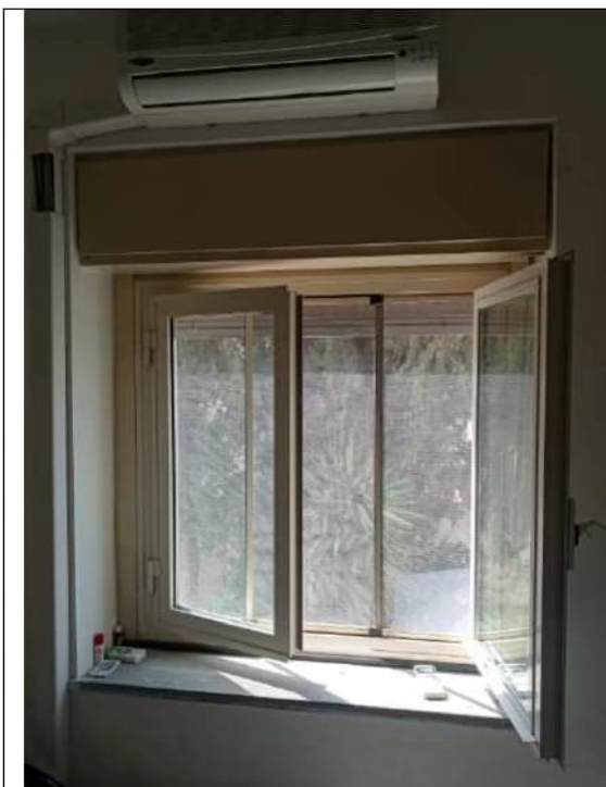
Foto 38. Particolare della tipologia di finestra interna a due ante, in alluminio, vetro doppio, con avvolgibili in pvc
