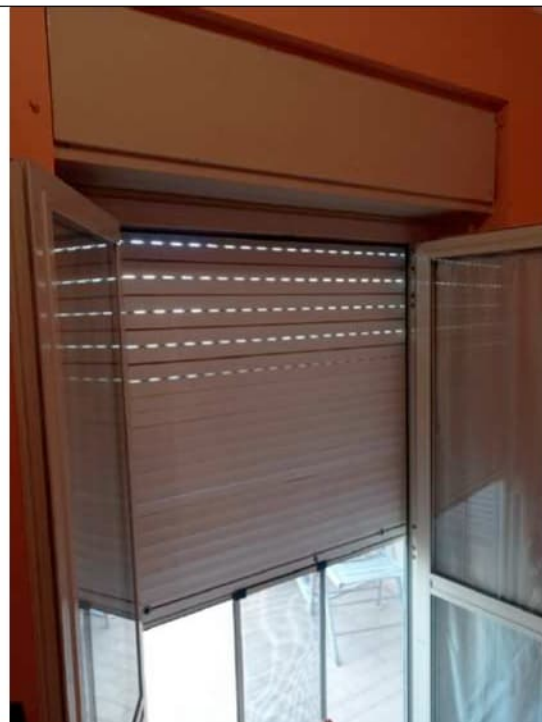
Foto 35. Particolare della tipologia di porta-finestra interna a due ante, in alluminio, vetro doppio, con avvolgibili in pvc
