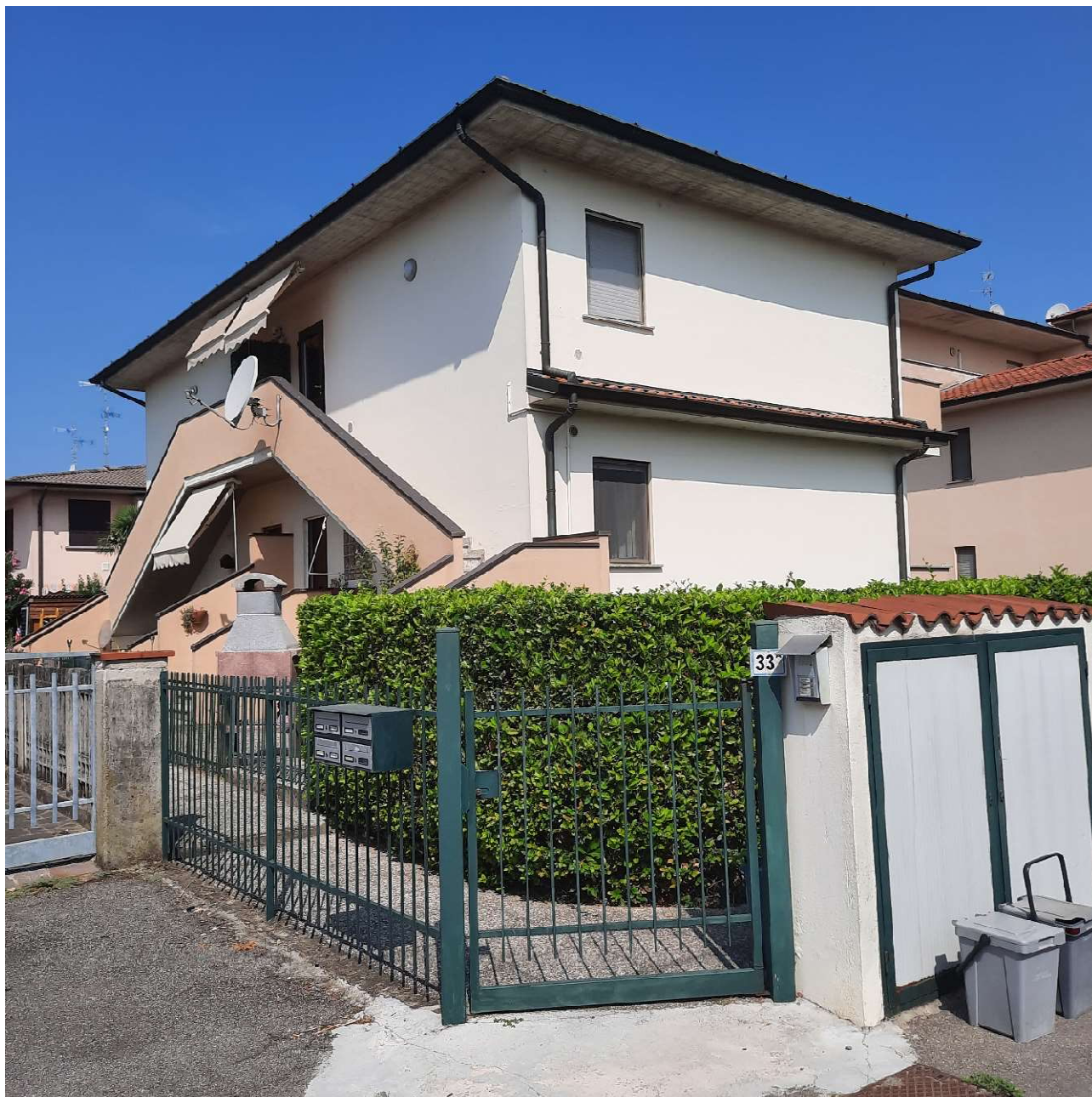
Foto 1 - fronte Via Braccola 33/a: accesso pedonale condominiale
