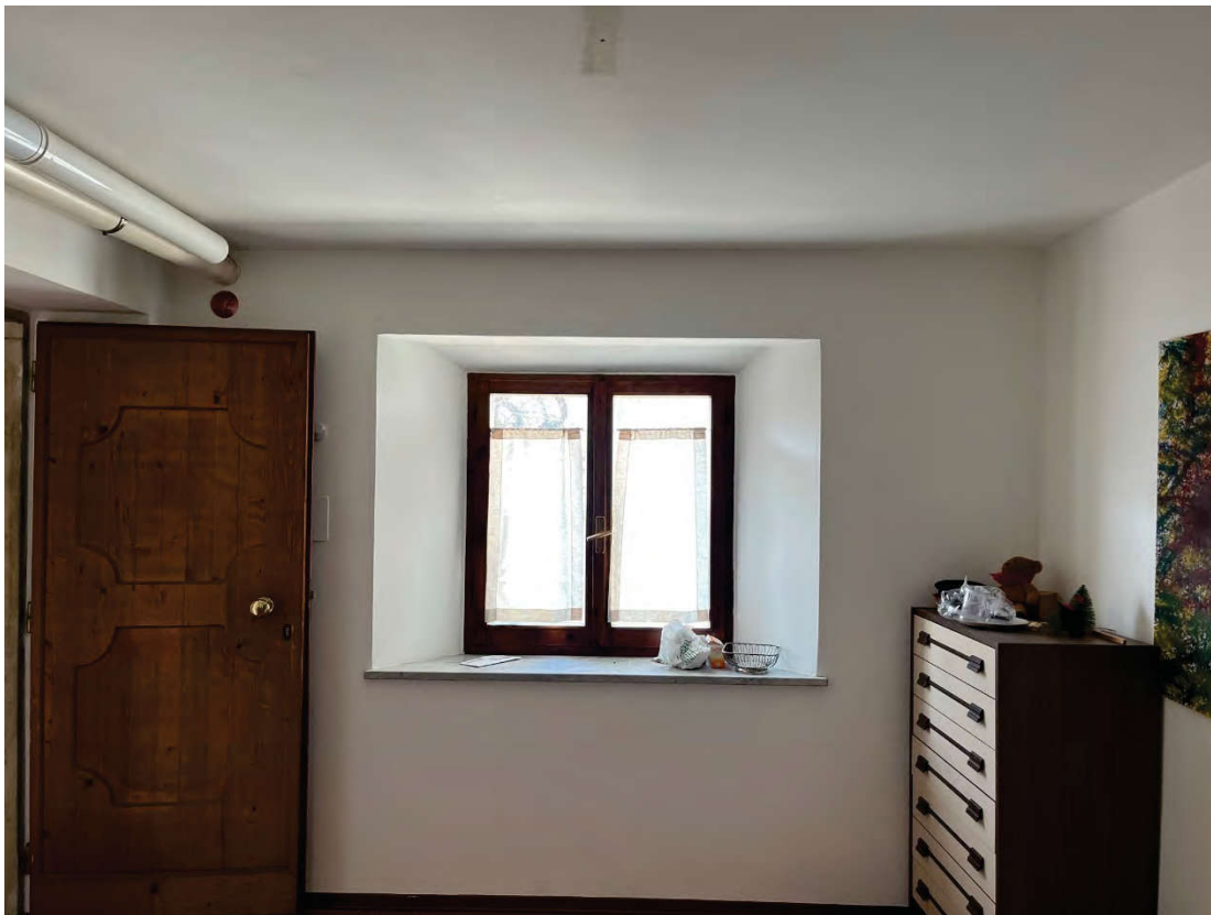
Locale piano ammezzato
