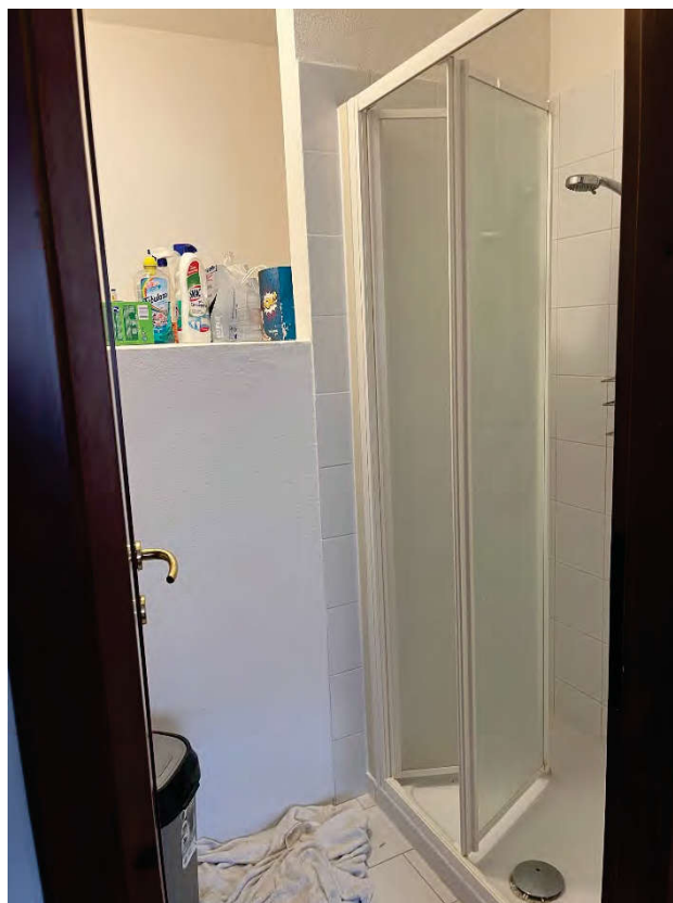
Doccia piano ammezzato
