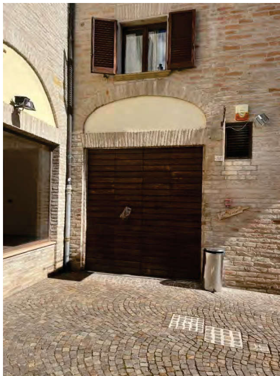
Ingresso al locale commerciale al civico 53 b
