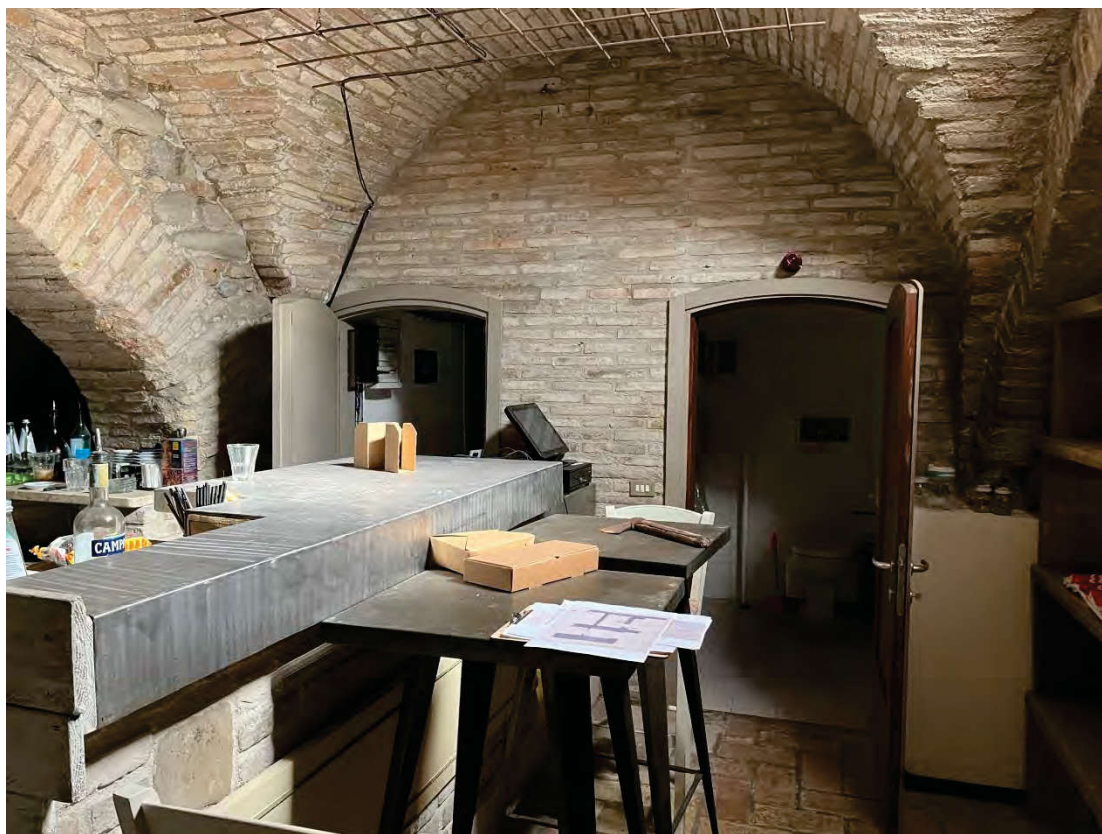
Vista verso bagno disabili e ripostiglio piano seminterrato
