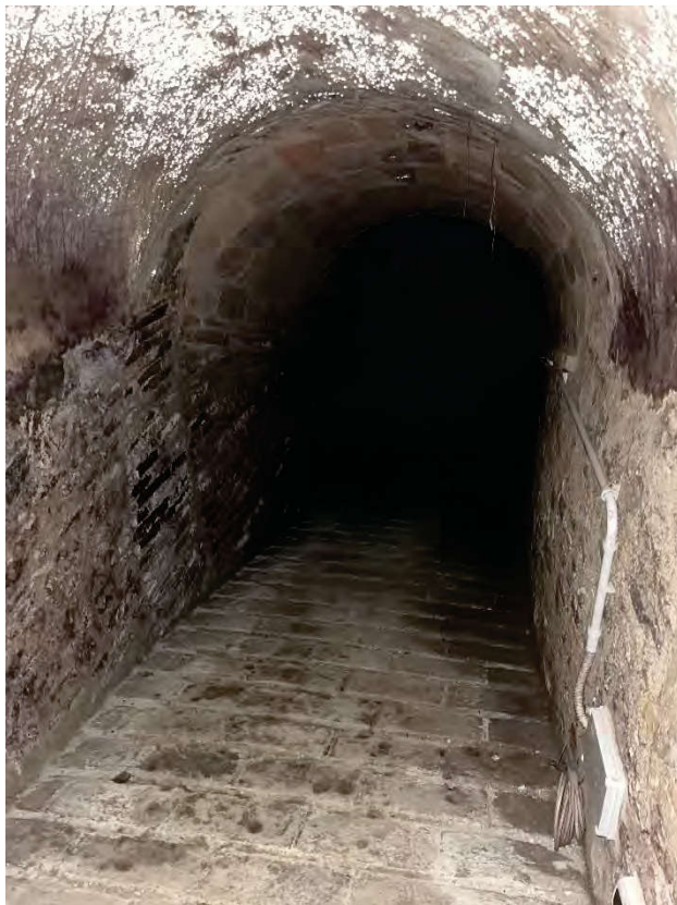
Accesso alle grotte dal piano seminterrato
