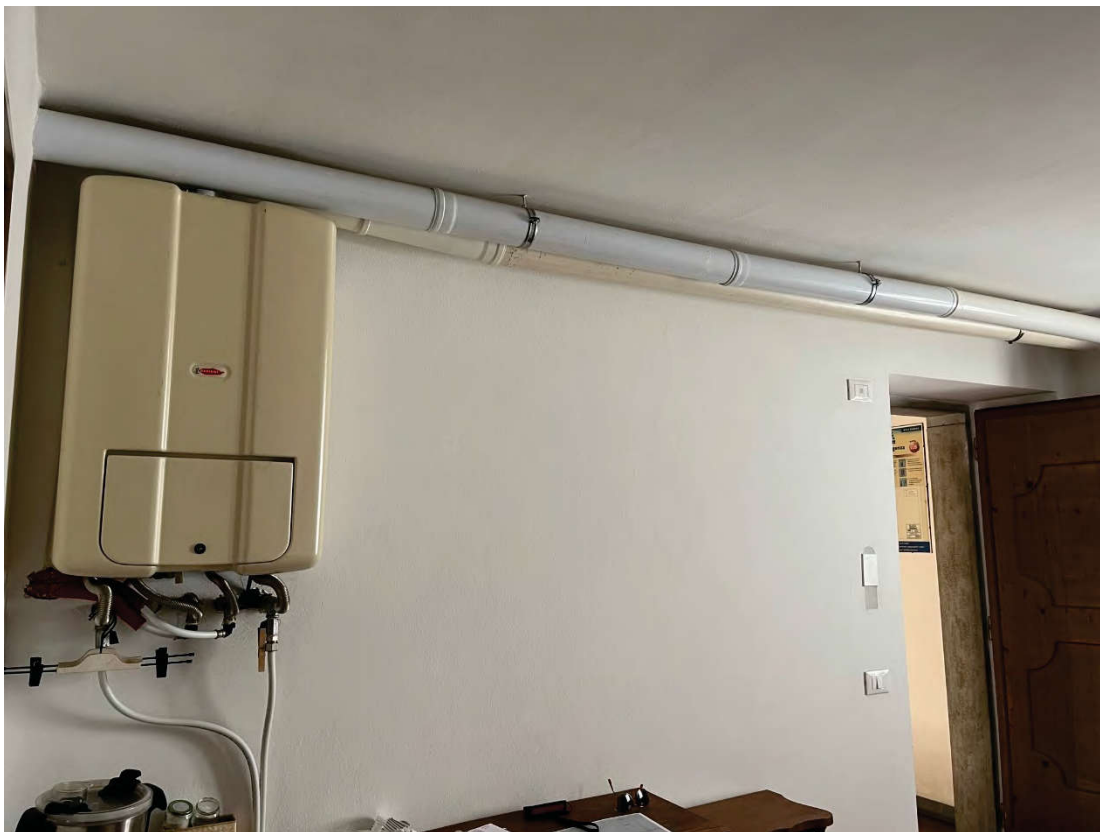
Locale piano ammezzato
