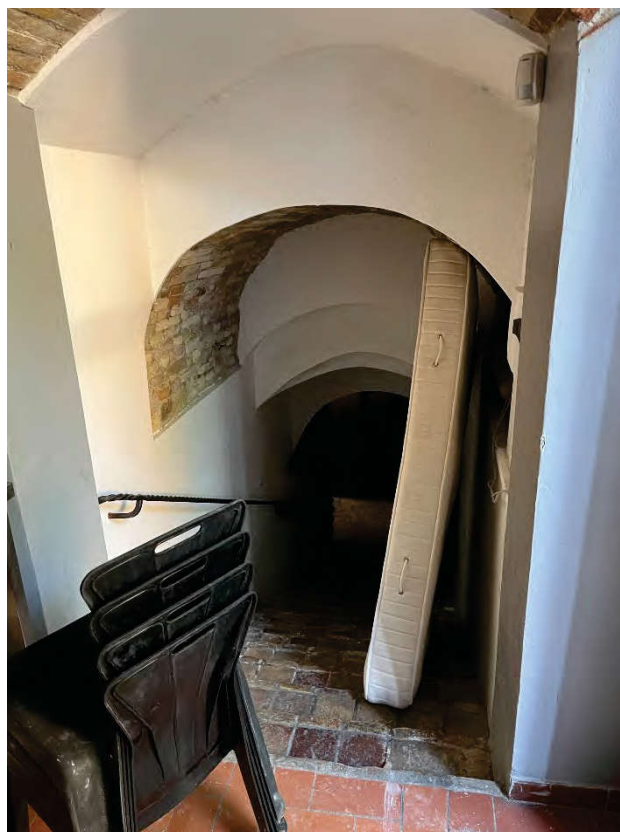
Accesso dalla cucina al piano seminterrato
