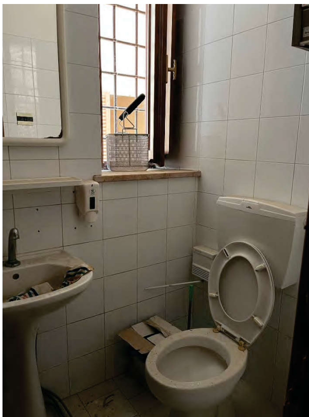
Wc cucina piano terra
