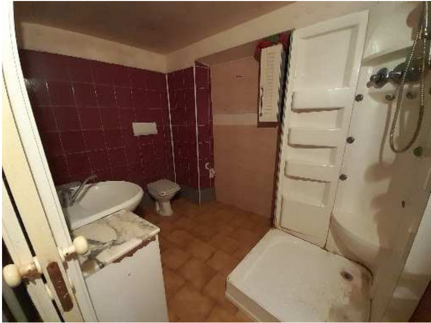
FOTO N. 05 vista interna piano secondo bagno
