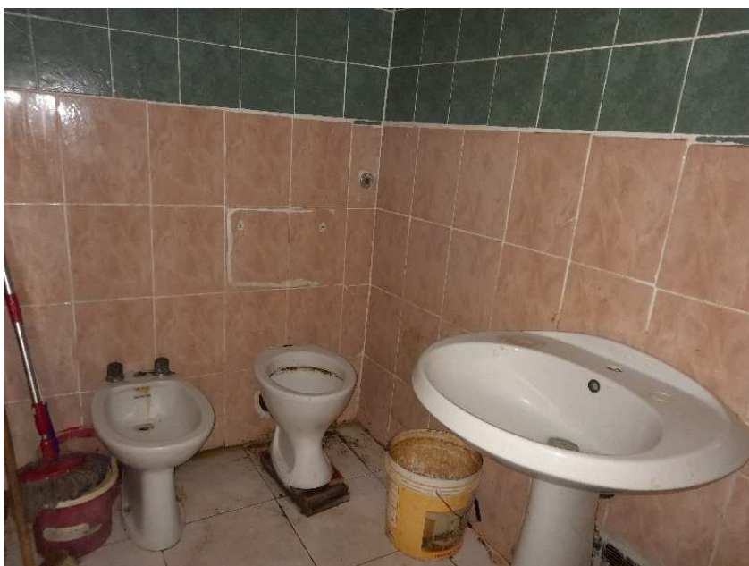
FOTO N. 03 vista interna piano terra bagno
