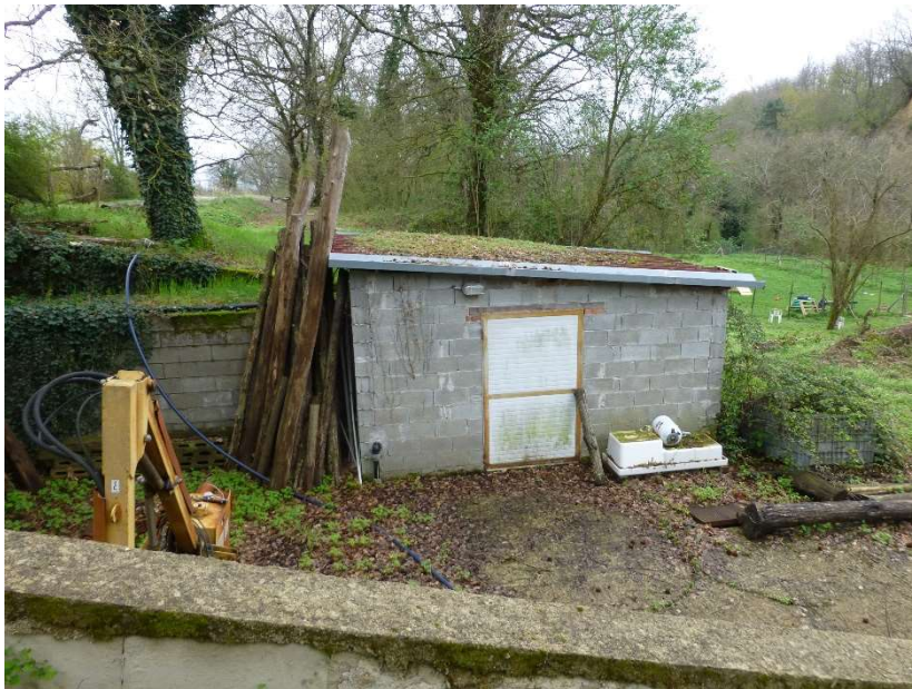
FOTO 28 – Concimaia con vano tecnico depuratore e scarico
