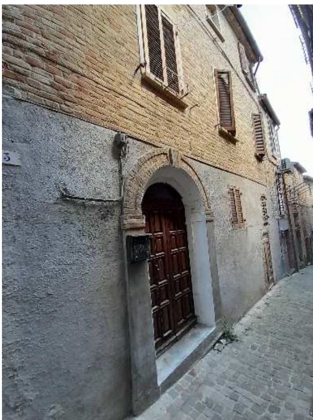
FOTO N. 01 vista prospettica ingresso su via Famiglia Masini
