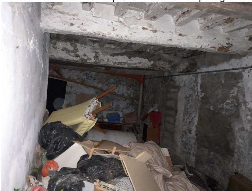
FOTO N. 02 vista interna piano terra stanza ripostiglio/lavanderia
