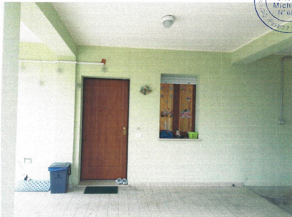
FOTO n.4 – vista dell'altro ingresso all'appartamento (sub. 11) dallo scoperto comune.
