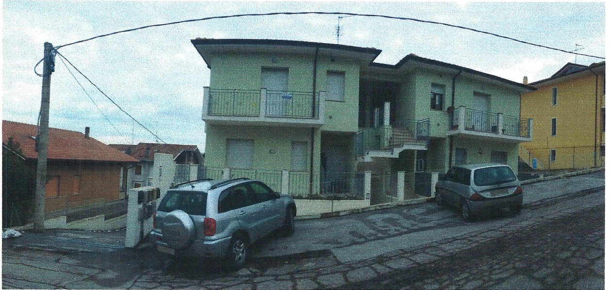
FOTO n.1 – vista del prospetto fronte del fabbricato da viale Cadore.
