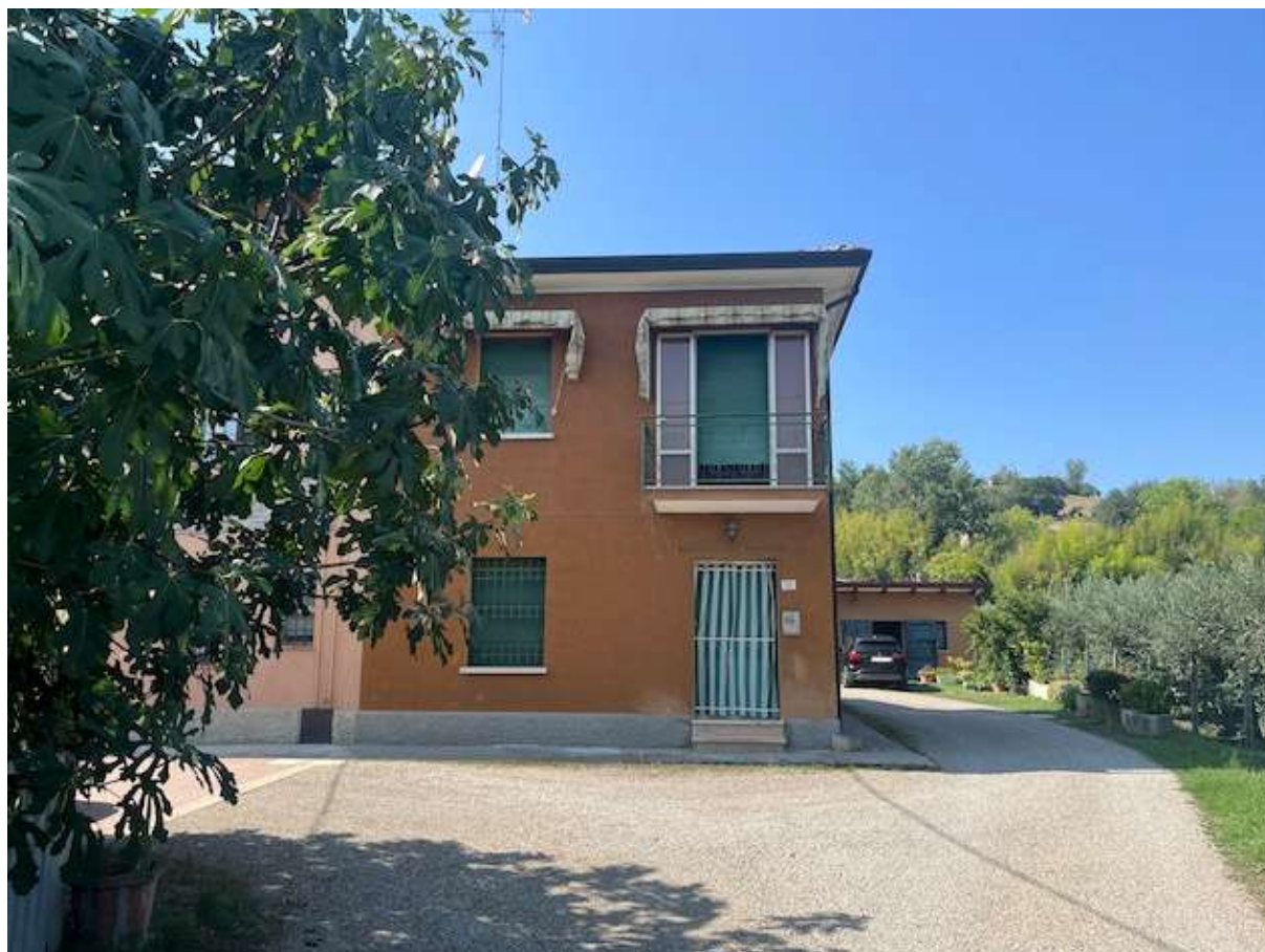
Lo stabile di cui l'immobile è parte
