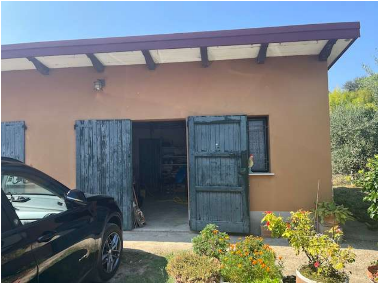
L'esterno del vano ad uso magazzino
