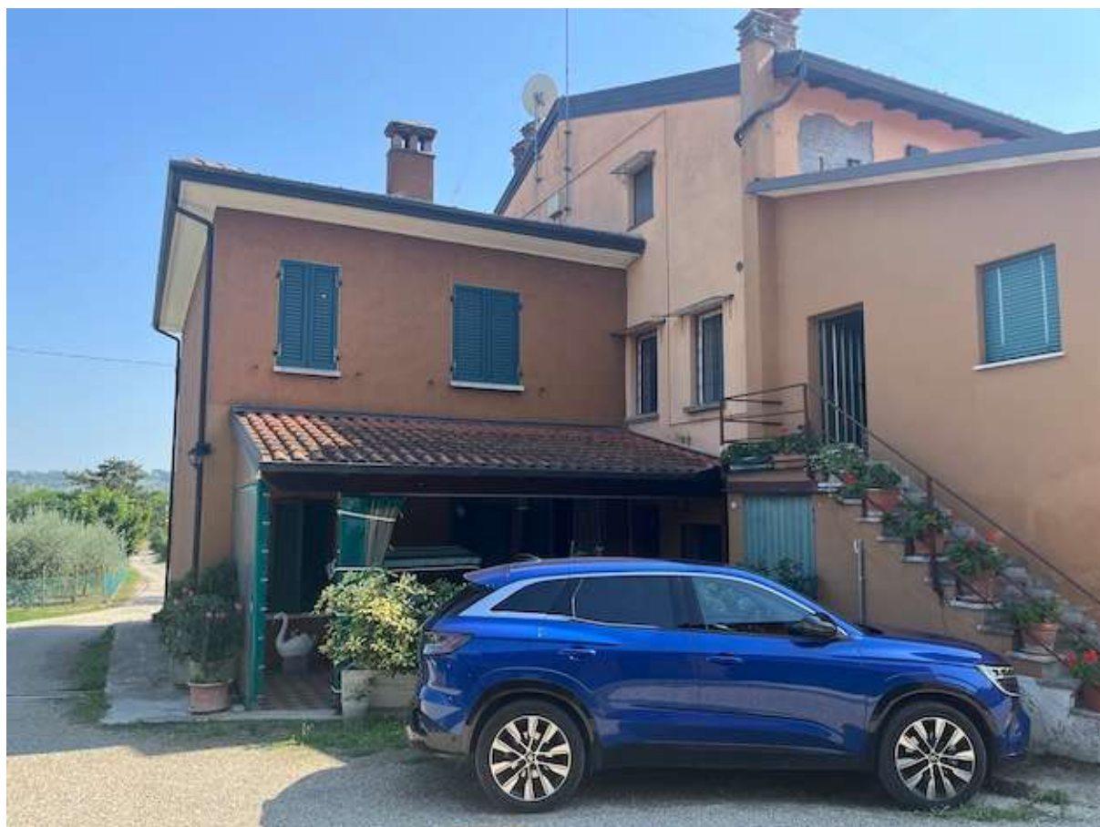
Lo stabile di cui l'immobile è parte
