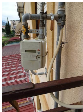
Contatore del gas.
