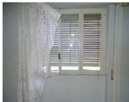
Particolare della finestra della camera da letto n.2.
