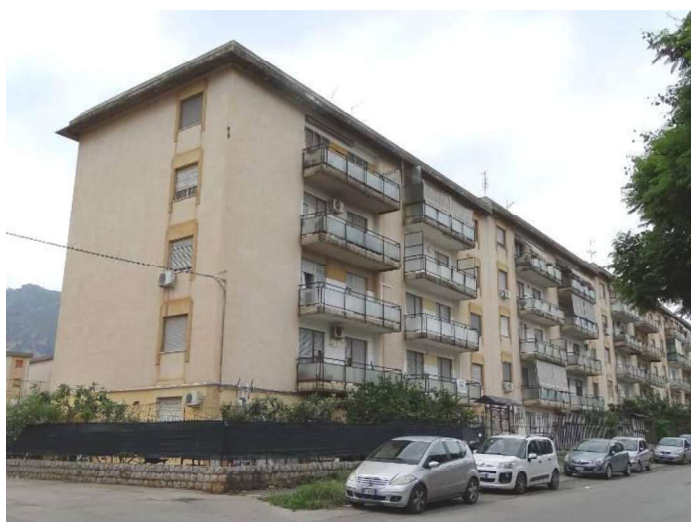
Edificio sito a Palermo in via Villagrazia n.100. Prospetto
