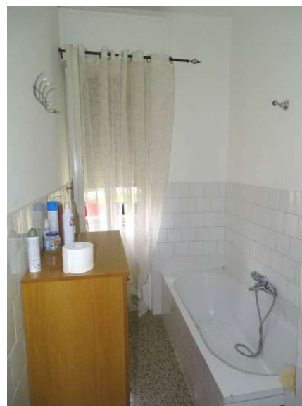
Locale wc con vasca da bagno.
