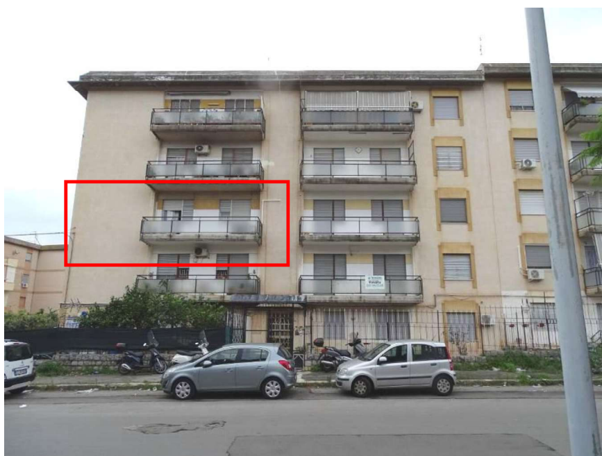
Edificio sito a Palermo in via Villagrazia n.100 in cui è ubicato l'immobile pignorato.
