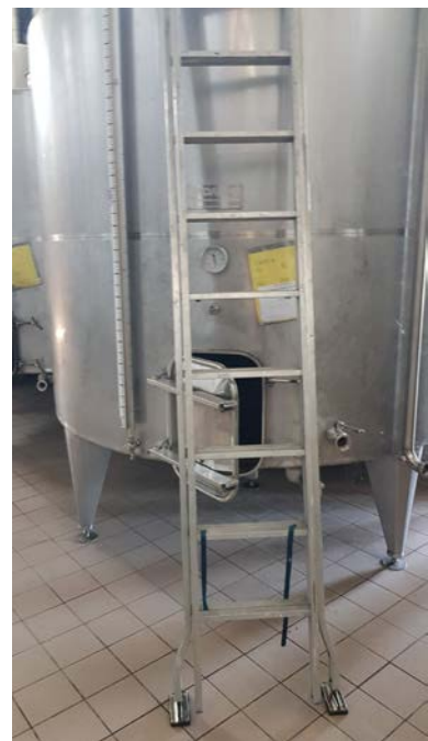
35C e 35D Vasche in acciaio inox refrigerate da 100 hl della Ditta Cadalpe, a fondo piano leggermente inclinato verso il boccaporto a raso. Utilizzabili per vinificazione in rosso con estrazione manuale
