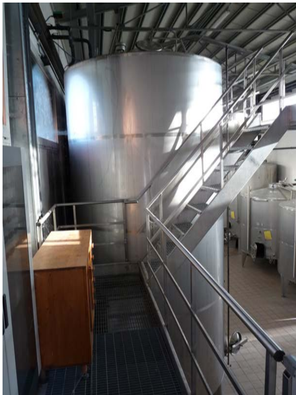
38 Passerella di collegamento ai fini della sicurezza. In acciaio inox lunghezza 30 m circa
