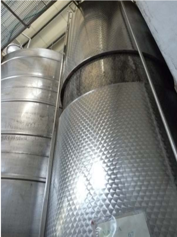
36A e 36B Vasche in acciaio inox refrigerate da 50 hl
