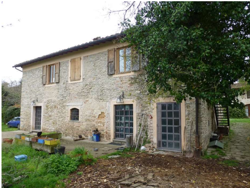
FOTO 4 – Vista del prospetto (Sud-Est)
