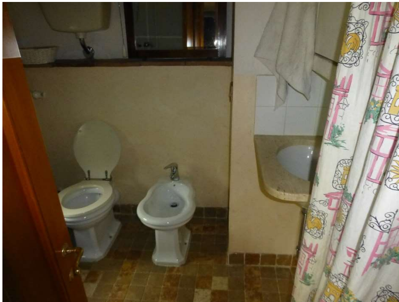
FOTO 61 – Vista del bagno al piano terra (31)
