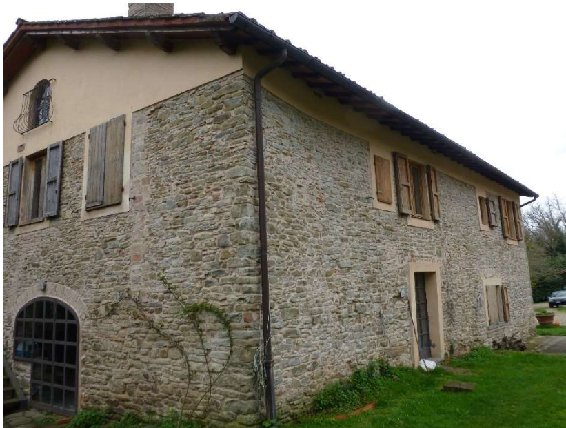
FOTO 5 – Vista del prospetto laterale (Nord-Ovest)
