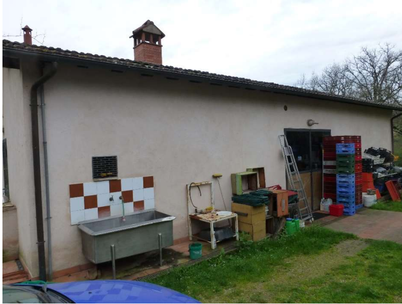
FOTO 23 – Vista del prospetto lato Nord-Ovest dei laboratori
