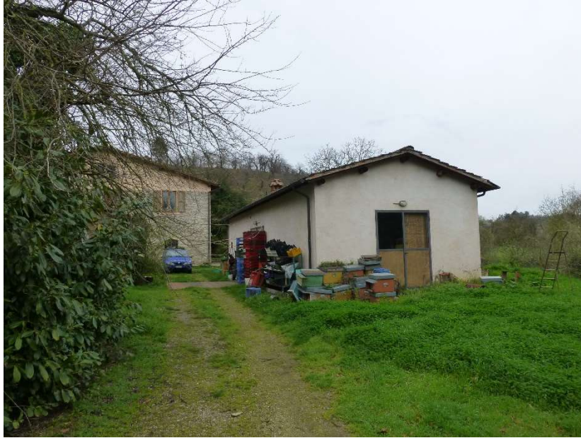
FOTO 21 – Vista del prospetto principale dei laboratori lato Sud-Ovest
