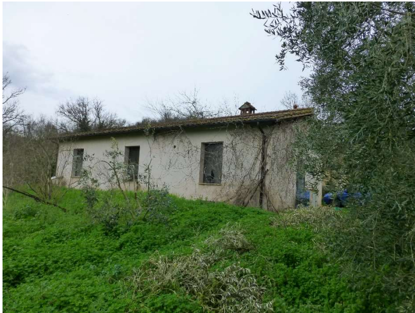
FOTO 22 – Vista del prospetto lato Sud-Est dei laboratori
