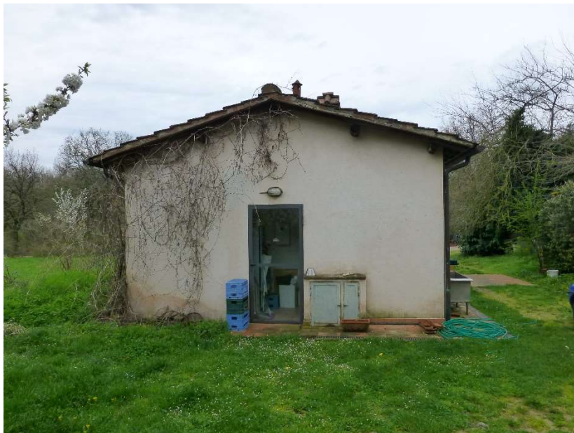
FOTO 24 – Vista del prospetto lato Nord-Est dei laboratori
