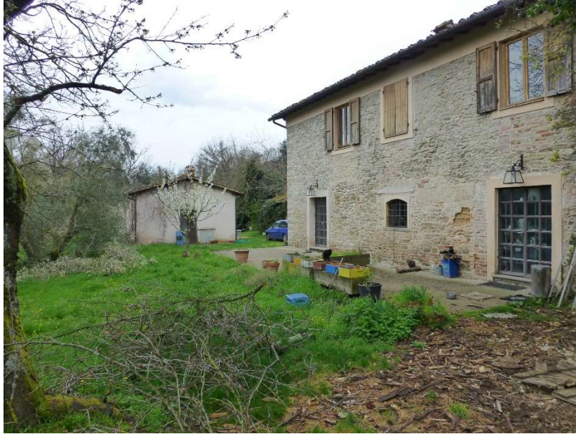
FOTO 26 – Vista dei laboratori e del fabbricato colonico lato (Sud-Est)
