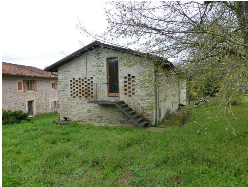
FOTO 2 – Vista del prospetto (Est)
