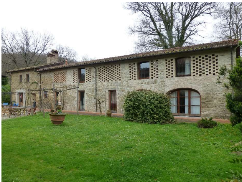
FOTO 8 – Vista del prospetto principale (Sud-Est)
