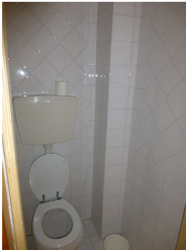
FOTO 69 – Vista del bagno (57)
