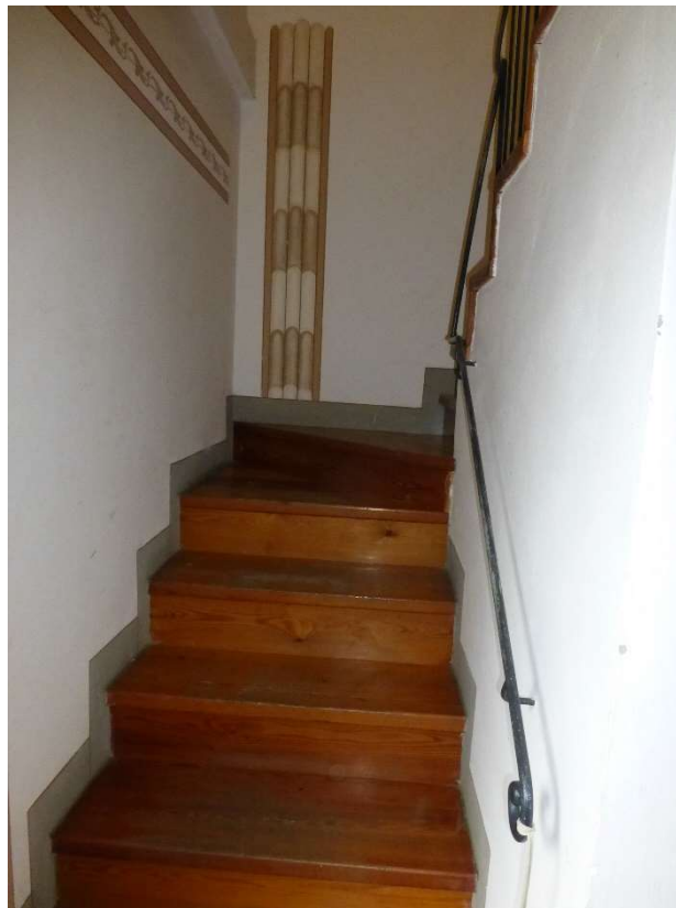
FOTO 74 – Vista del vano scale (42)
