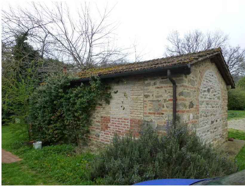
FOTO 16 – Vista del prospetto lato Sud-Est
