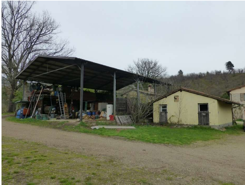
FOTO 10 – Vista della tettoia e della stalla lato Sud-Ovest
