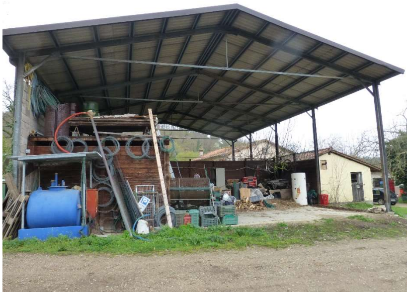
FOTO 13 – Vista del prospetto principale della tettoia (Ovest)
