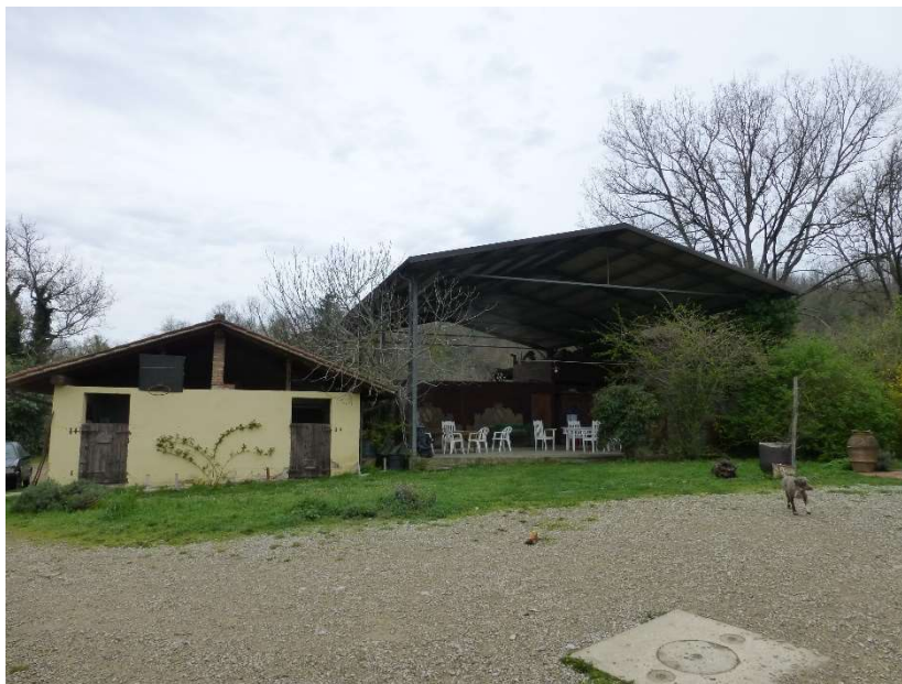
FOTO 11 – Vista della tettoia e della stalla lato Est
