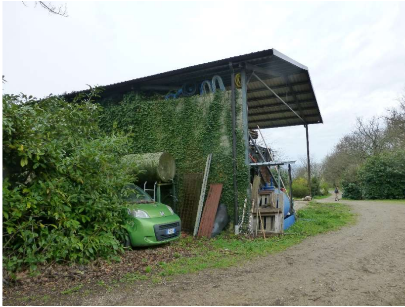
FOTO 12 – Vista della tettoia lato Nord-Ovest
