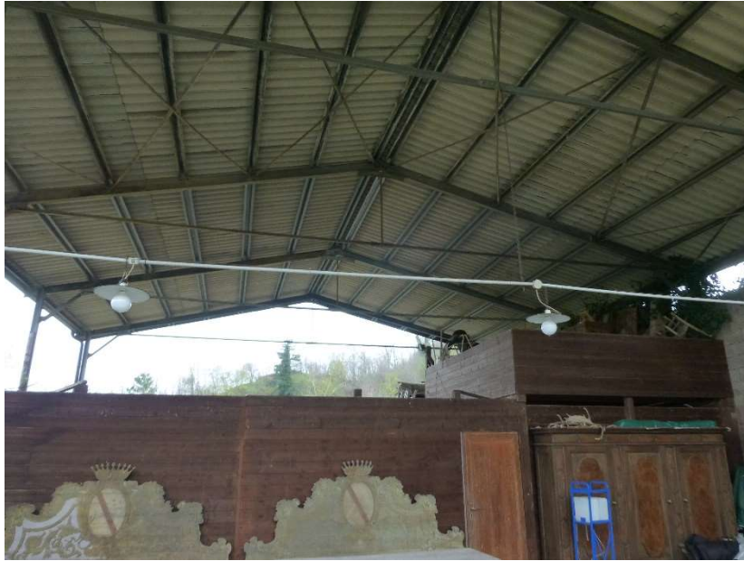
FOTO 90 – Vista interna la tettoia (70)
