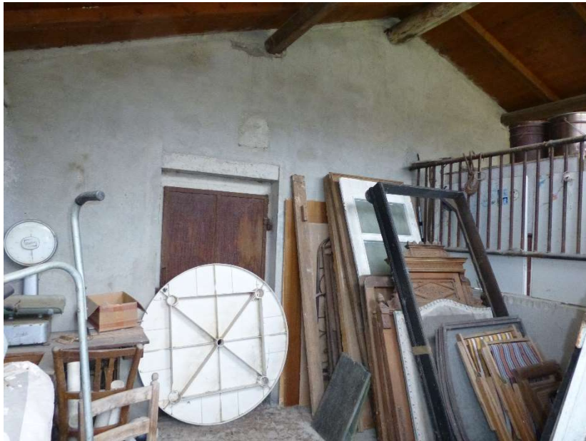
FOTO 91 – Vista interna della stalla (39)
