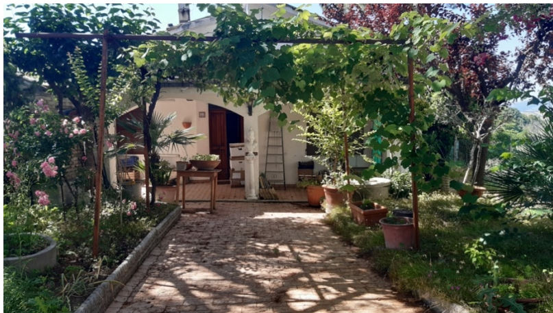
Figura 1 palazzina - facciata esterna con vista su corte
