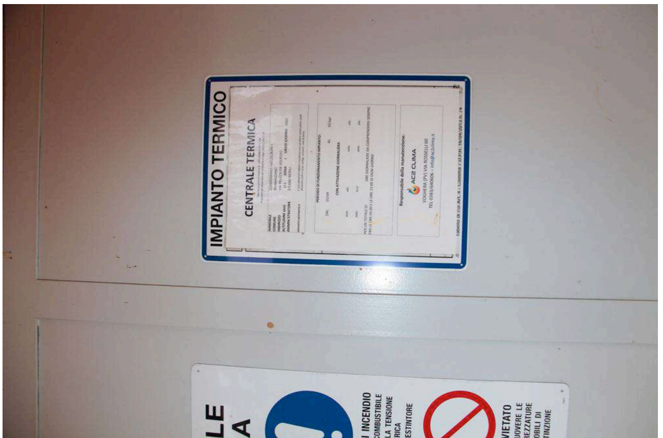
Foto n° 64 - Mappali 1142 sub 31 (Centrale Termica)
