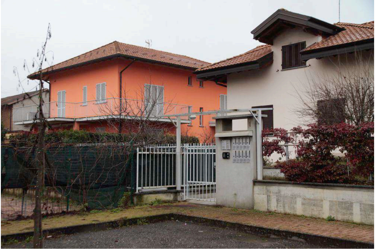
Foto n° 1 - Vista ingresso pedonale
