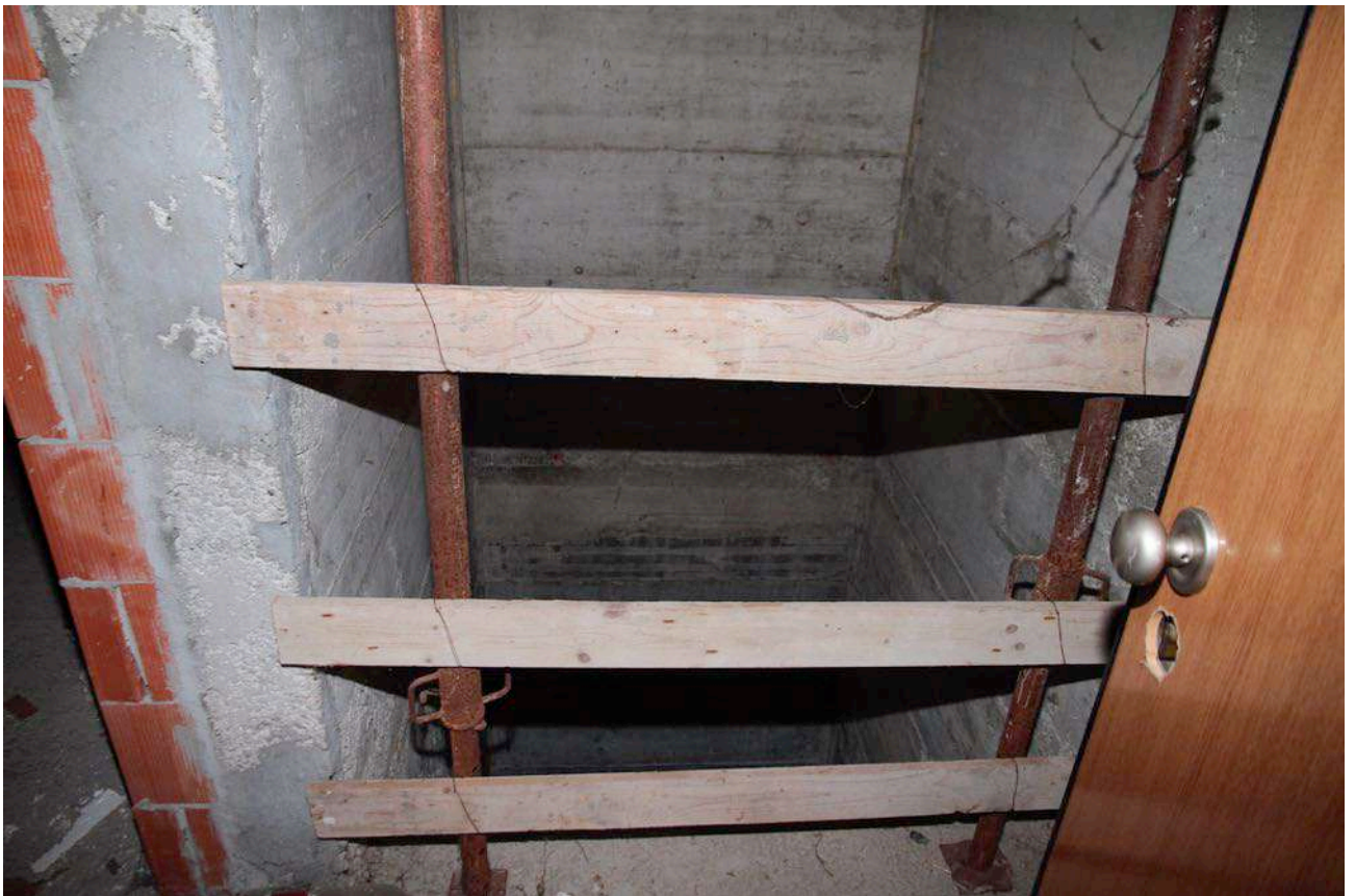
Foto n° 48 - Mappale 1142 sub 35 (vano ascensore)
