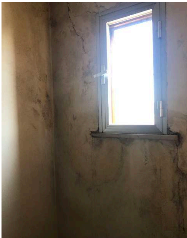
FOTO 33 - 1.a Appartamento - ripostiglio
