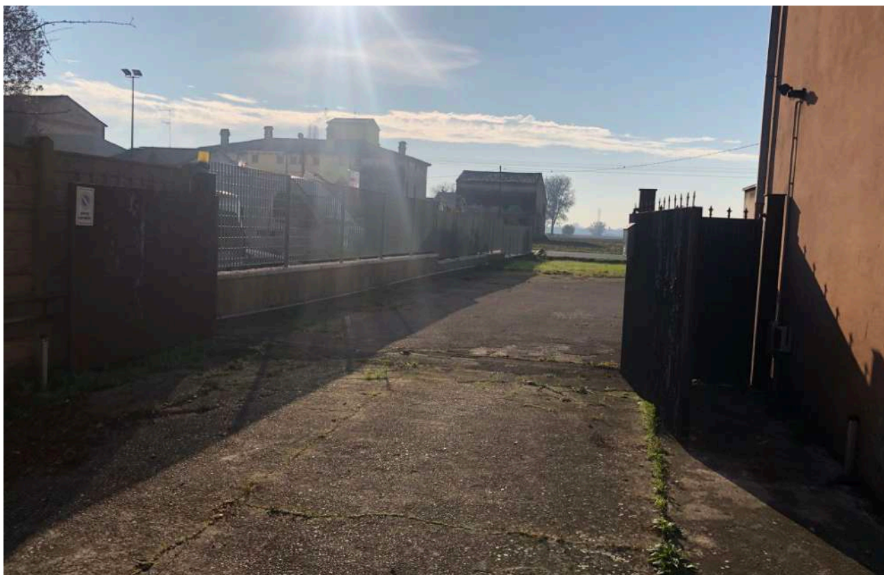
FOTO 5 - Ingresso lato Sud-Est
