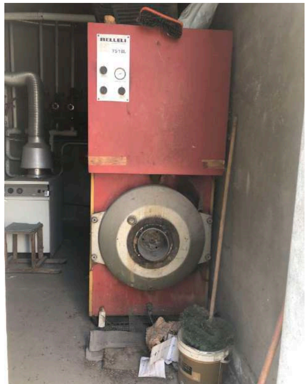
FOTO 77 - 1.d Laboratorio, piano terra
