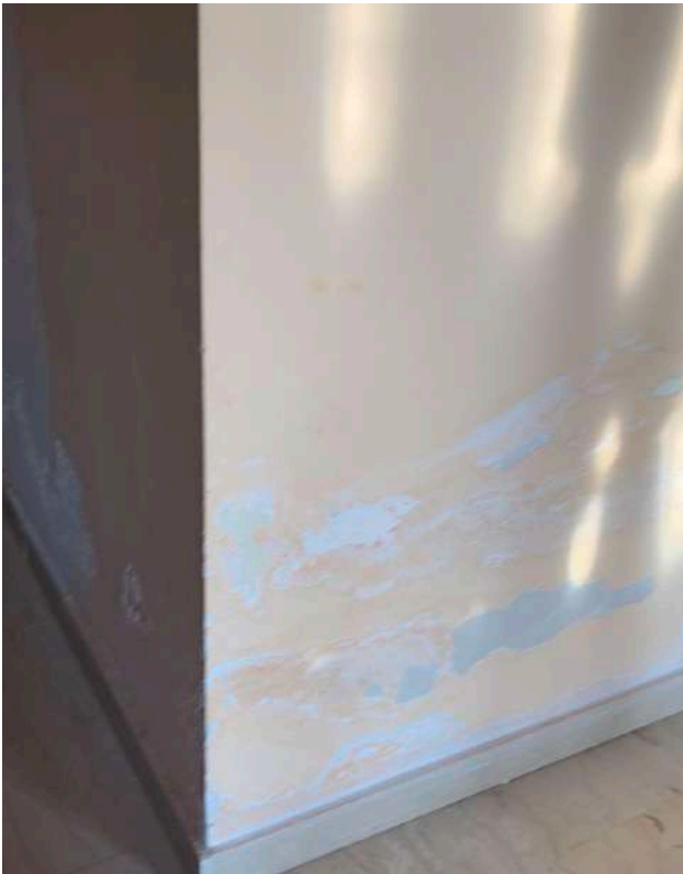
FOTO 28 - 1.a Appartamento - disimpegno
