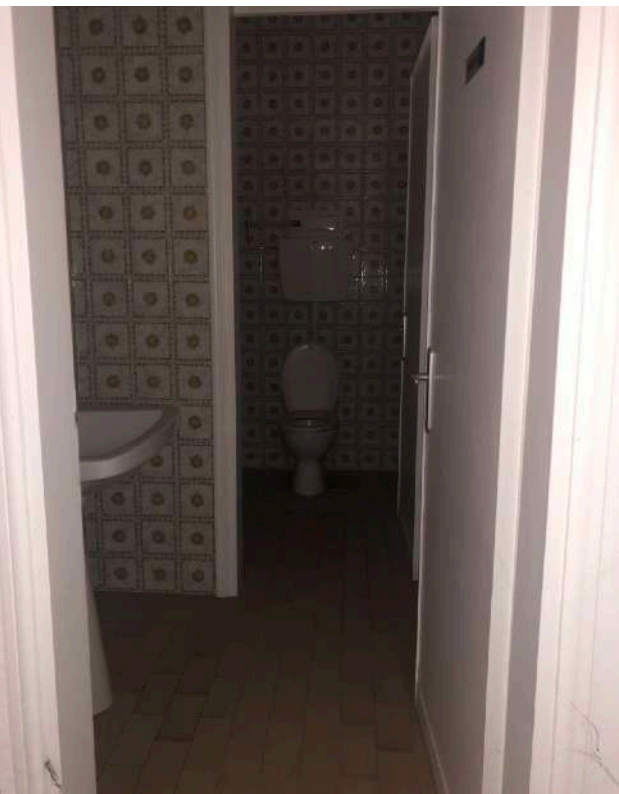
FOTO 63 - 1.d Laboratorio, piano terra
