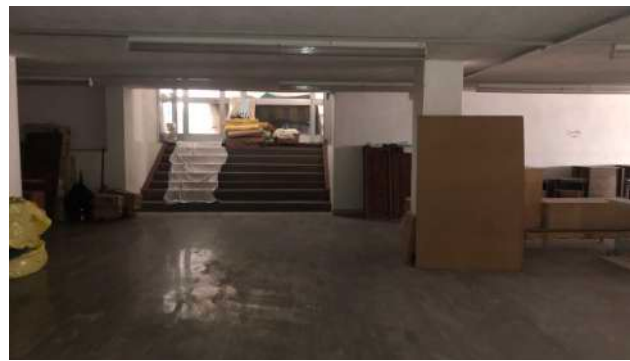
FOTO 57 - 1.c Negozio, piano seminterrato
