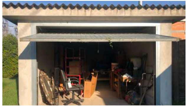
FOTO 37 - 1.b Autorimessa, piano terra
