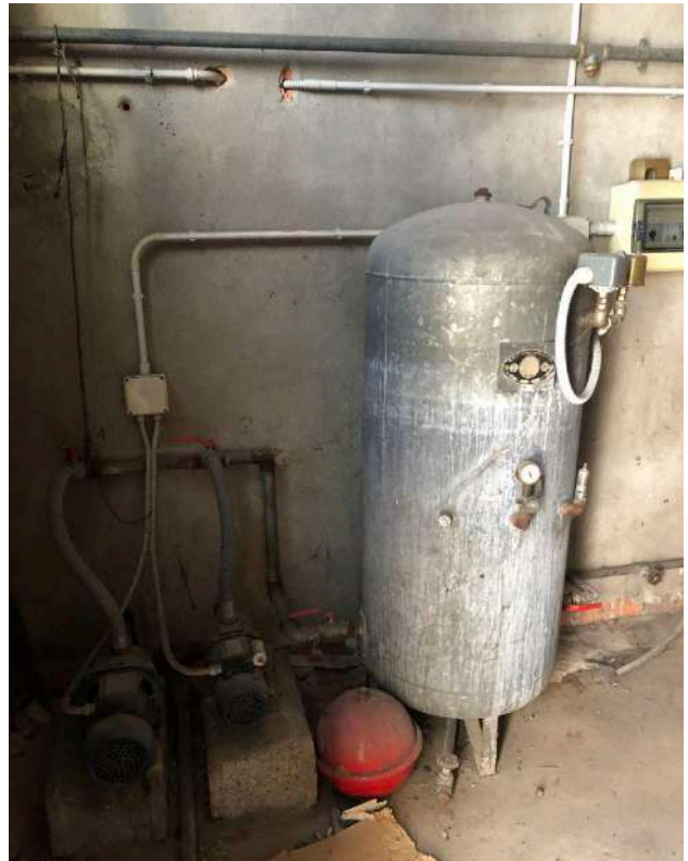
FOTO 79 - 1.d Laboratorio, piano terra
