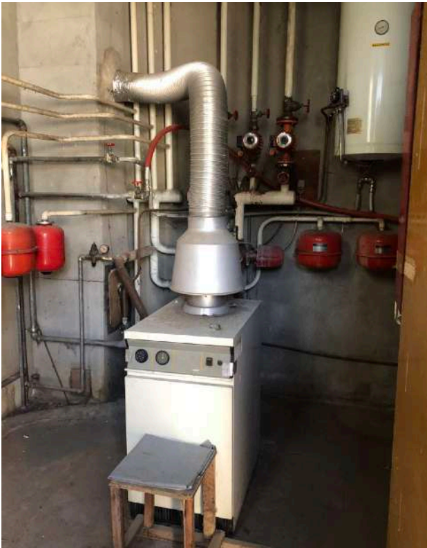
FOTO 78 - 1.d Laboratorio, piano terra
