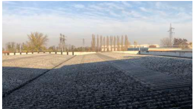
FOTO 73 - 1.d Laboratorio, piano terra
