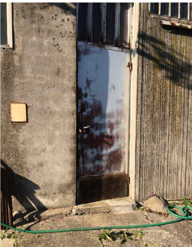
FOTO 76 - 1.d Laboratorio, piano terra
