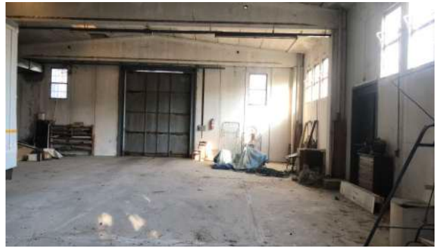
FOTO 66 - 1.d Laboratorio, piano terra
