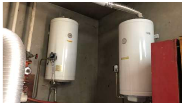
FOTO 75 - 1.d Laboratorio, piano terra
