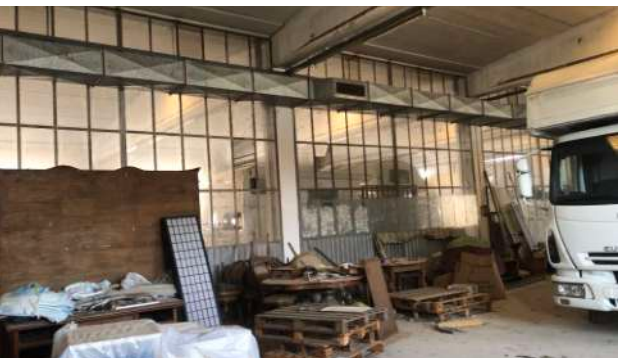
FOTO 70 - 1.d Laboratorio, piano terra
