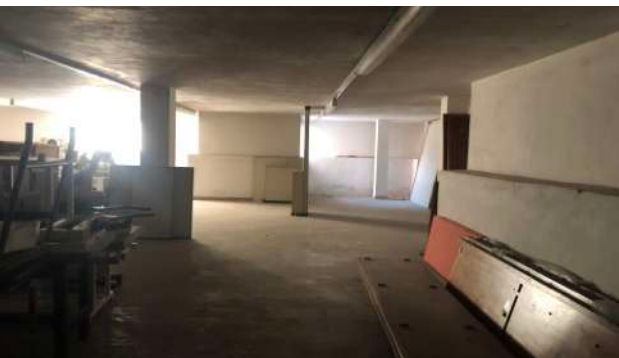
FOTO 58 - 1.c Negozio, piano seminterrato
