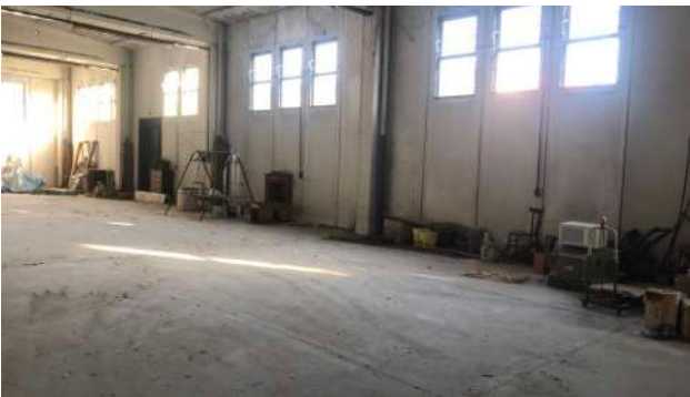
FOTO 67 - 1.d Laboratorio, piano terra
