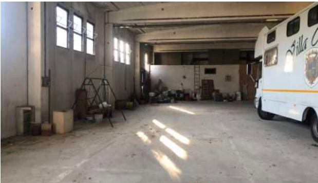
FOTO 72 - 1.d Laboratorio, piano terra
