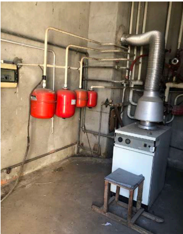
FOTO 80 - 1.d Laboratorio, piano terra
