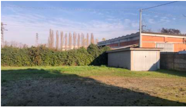
FOTO 36 - 1.b Autorimessa, piano terra
