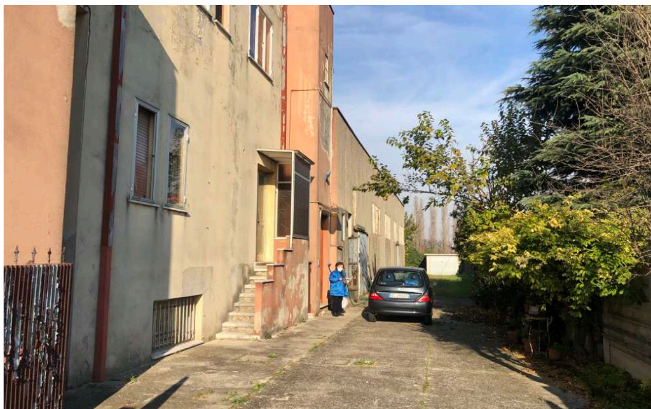
FOTO 6 - Ingresso lato Sud-Est
