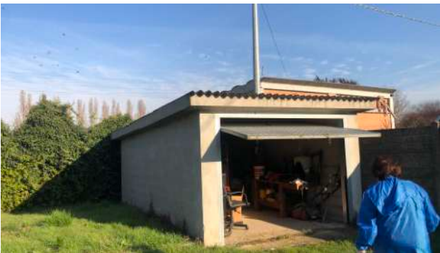
FOTO 38 - 1.b Autorimessa, piano terra
