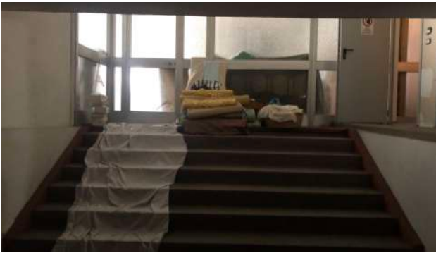
FOTO 60 - 1.d Laboratorio, piano terra
