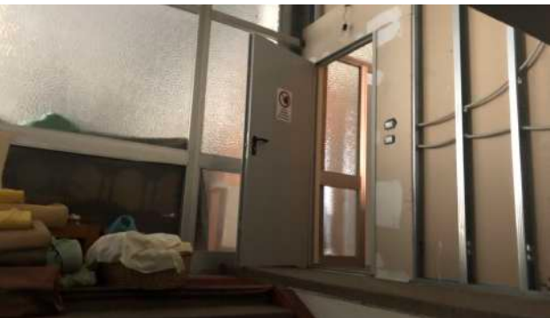
FOTO 61 - 1.d Laboratorio, piano terra
