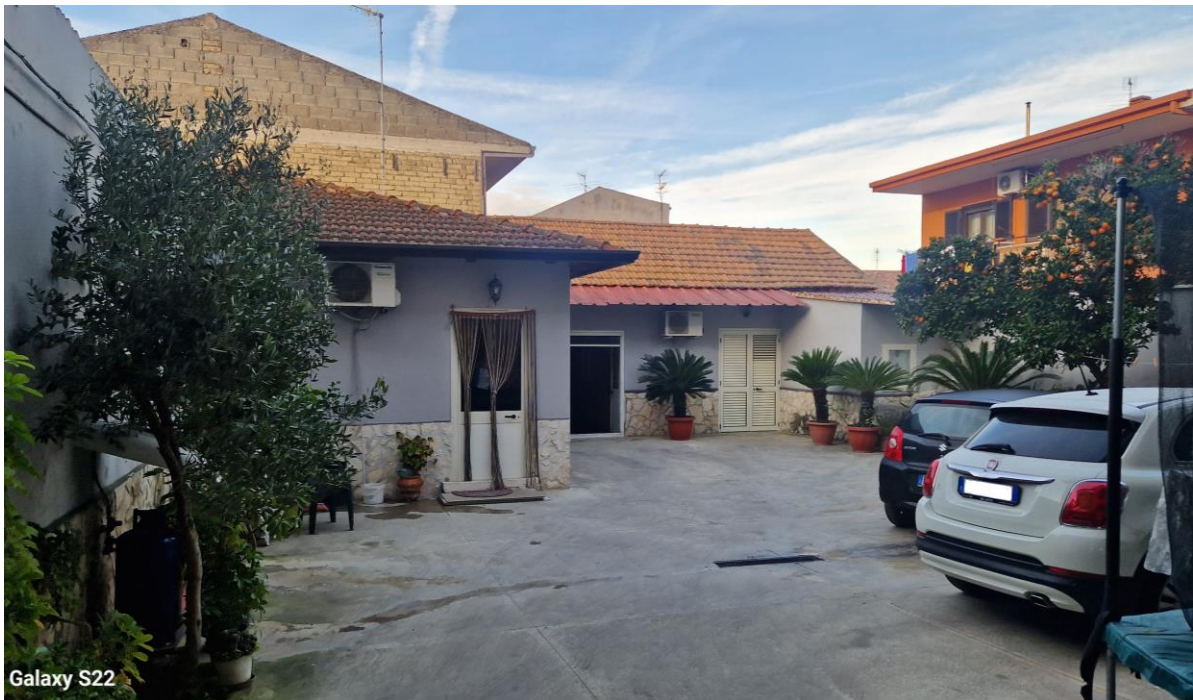
VISTA ESTERNA LATO CORTE
