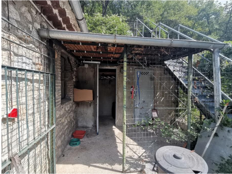
Il fabbricato rurale p.lla 15 – per accedervi si entra nella proprietà recintata da terzi
