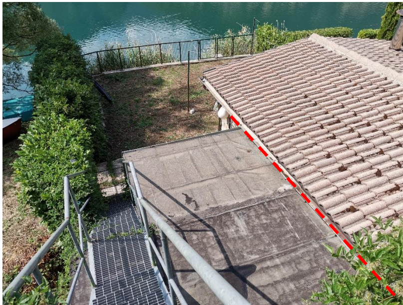
La copertura del fabbricato rurale p.lla 15 – per accedervi si entra nella proprietà recintata da terzi
