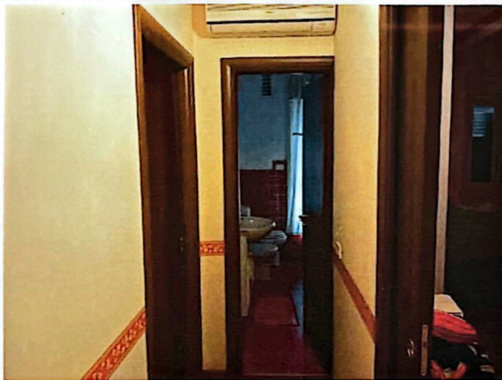
Foto 4: Vista del corridoio a primo piano
