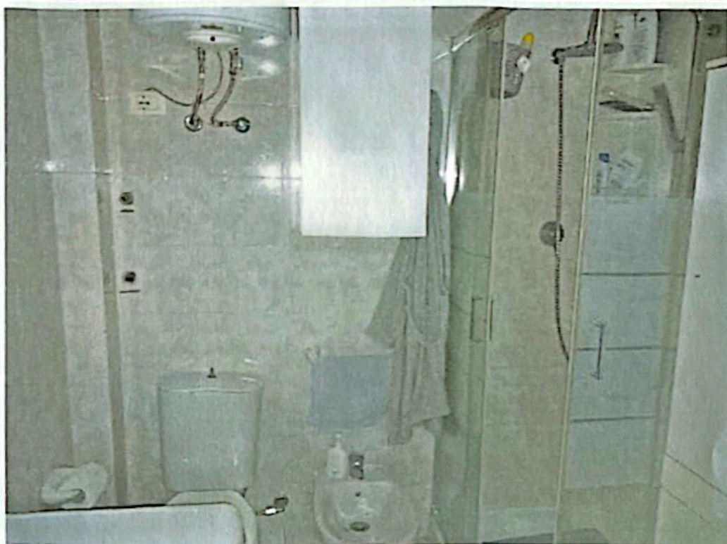
Foto 8: Vista del bagno al piano secondo
