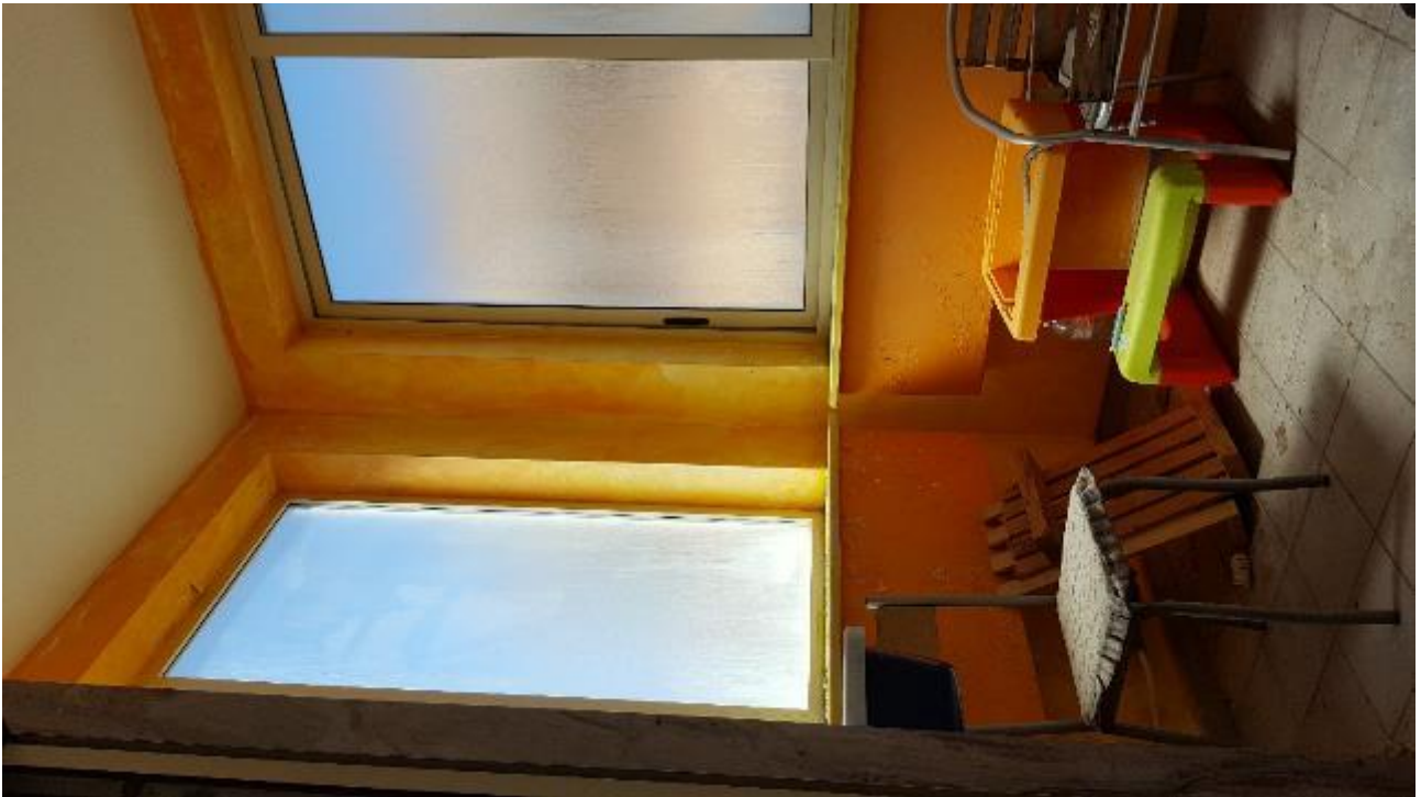
11 - Veranda attualmente chiusa con infissi da rimuovere.
