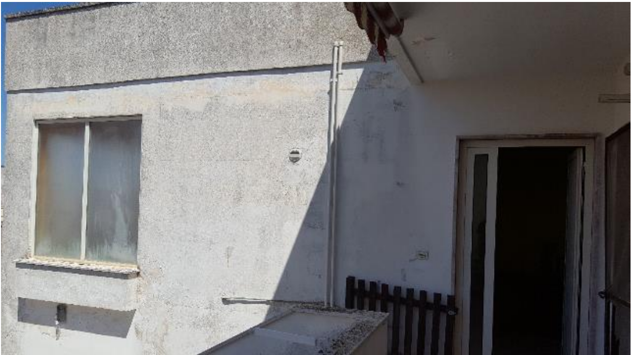
06 - Fronte principale. Sulla sinistra chiusura da rimuovere della veranda; sulla destra ingresso alla cucina.
