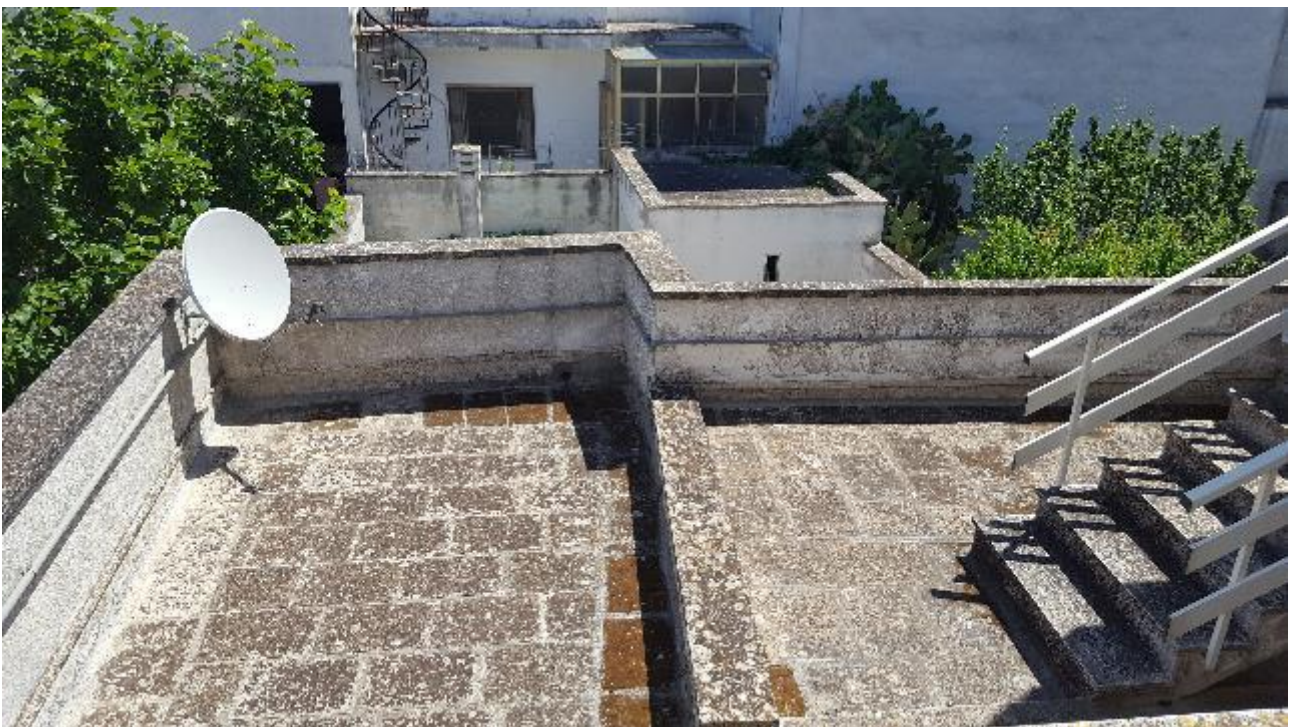
20 - Terrazzo sul retro, vista verso nord-est.
