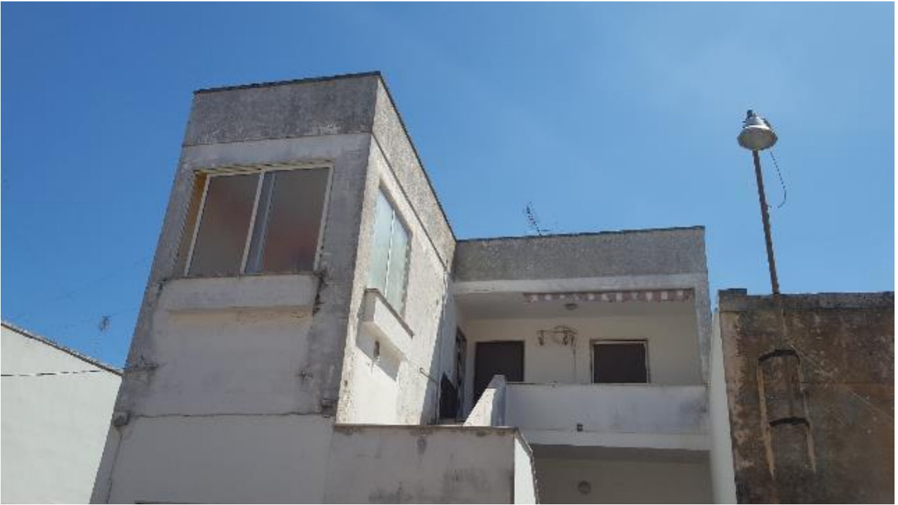
01 - Abitazione oggetto di pignoramento posta a piano primo del fabbricato su due piani fuori terra su via Giuseppe Verdi.
