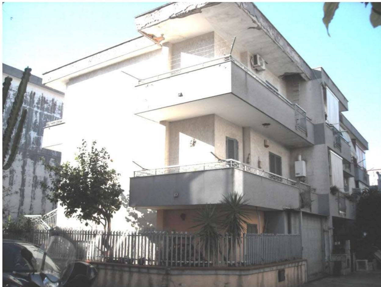
Foto n.3: Vista assonometrica Villetta a schiera unifamiliare, lato nord-est.
