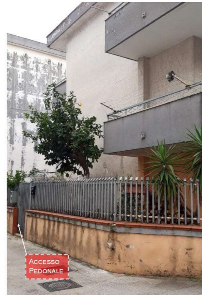
Foto n. 4: Accesso pedonale, lato est.
