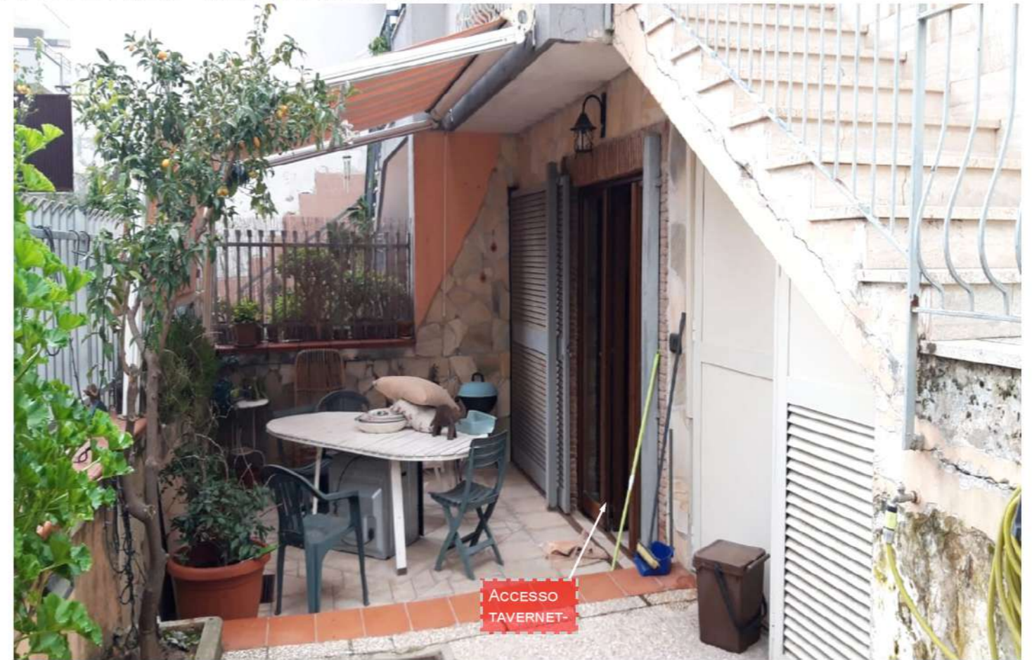
Foto n.8: Area di corte pertinenziale alla tavernetta del piano terra, lato sud..
