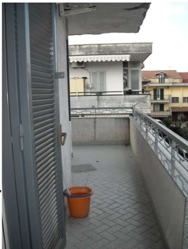
Foto n. 22: Balcone antistante cameretta, con sviluppo angolare da nord ad est su via San Giovanni.
