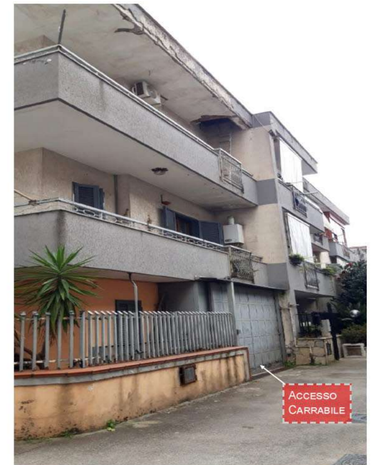
Foto n. 5: Accesso carrabile, lato nord.
