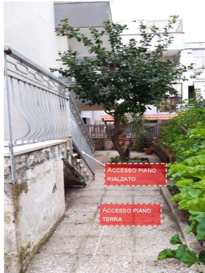
Foto n.7: Vista scala d'accesso al piano rialzato, lato est..
