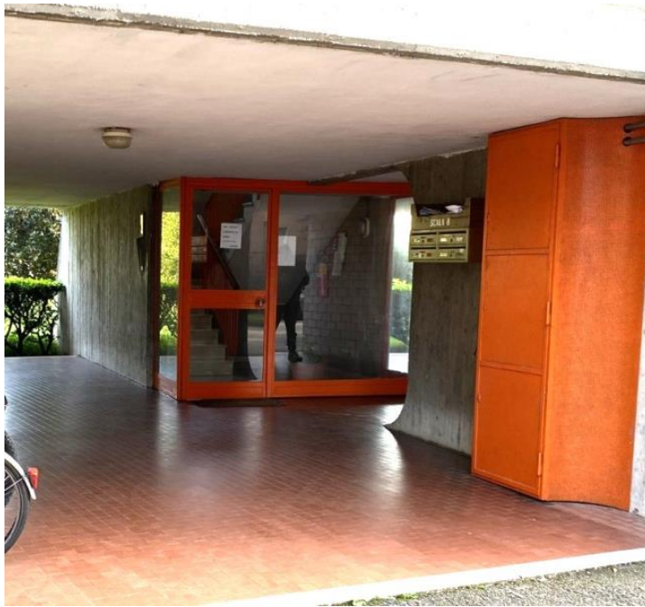
Porta metallica della Scala B
