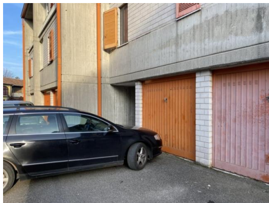
Basculante del box al centro della foto
