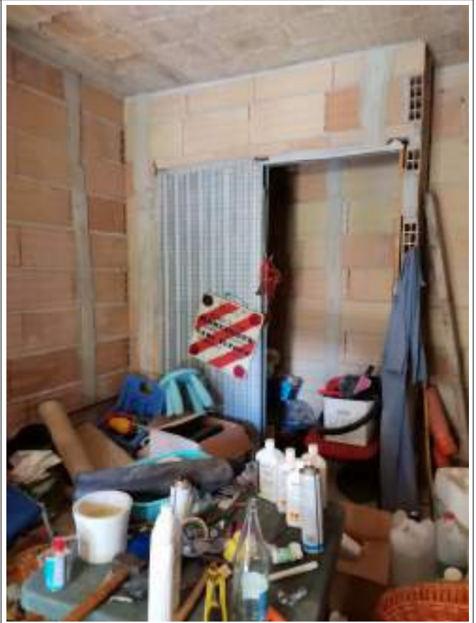
Piano terra locale ingresso
