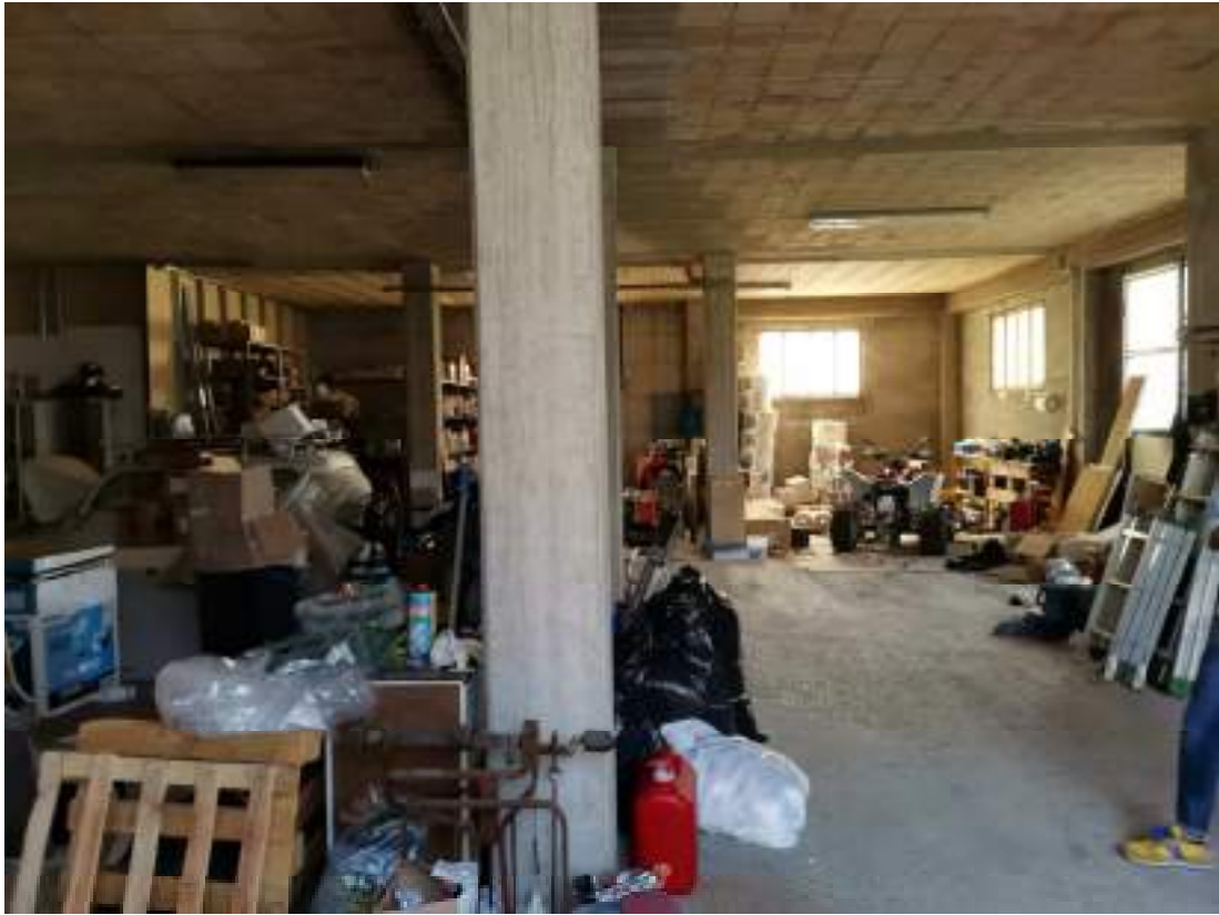
Lesioni pareti interne
