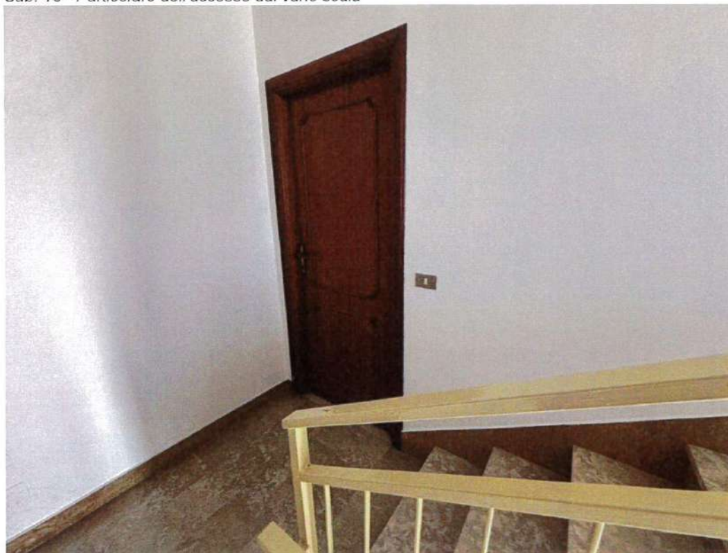
Fotografia n° 04 Sub. 16 - Particolare dell'accesso dal vano scala
