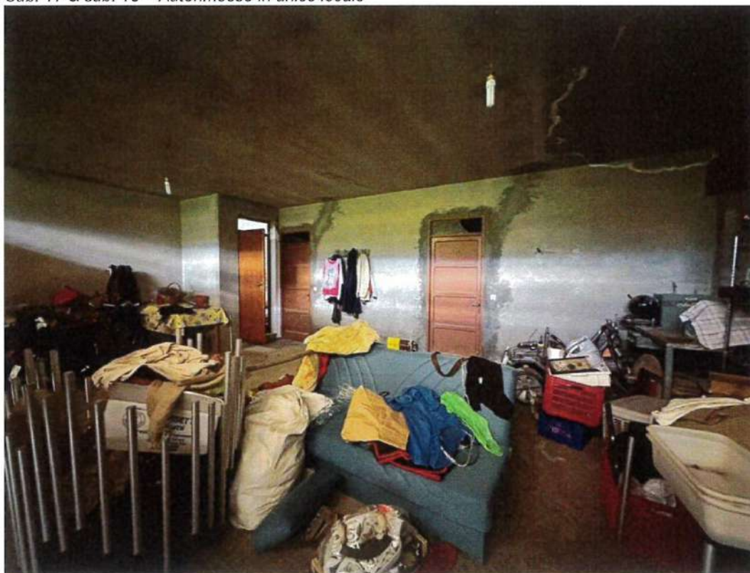
Fotografia n° 19 Sub. 17 & sub. 18 – Autorimesse in unico locale
