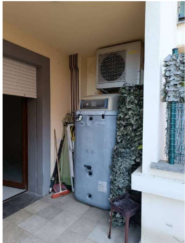
Figg. 26-28 Appartamento Sub. 98 Int. D/4 PT - Loggia esterna con accesso dal soggiorno; Pompa di calore e Serbatoio accumulo ACS
