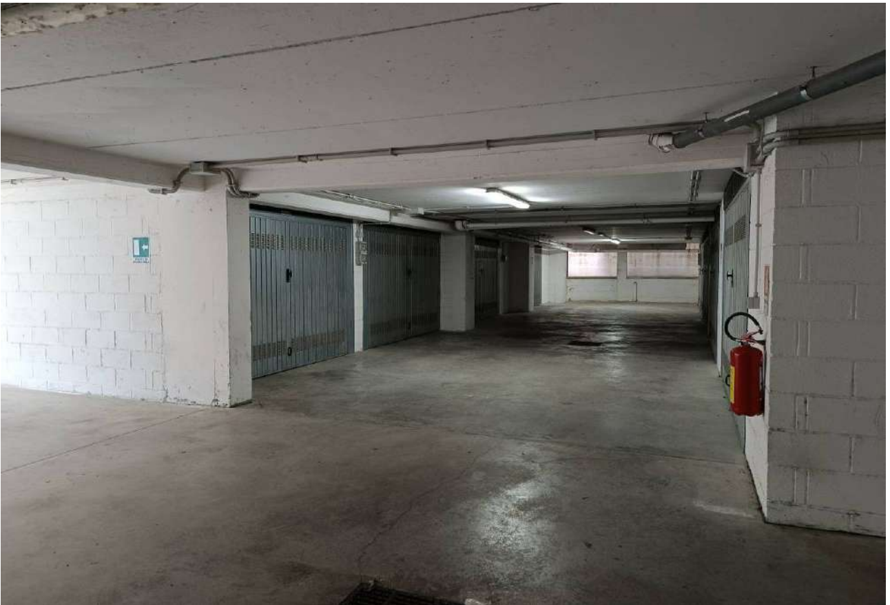
Figg. 31-32 Box Sub. 20 Int. 12 PS1 - Autorimessa interrata: (sopra) rampa di accesso su fronte NordEst; (sotto) spazi di manovra interni
