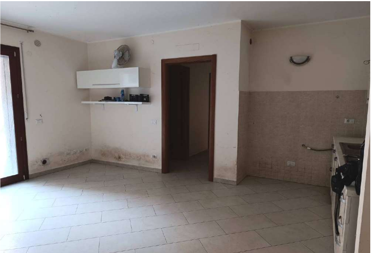
Figg. 10-11 Appartamento Sub. 98 Int. D/4 PT – Soggiorno/pranzo/A.C., con accesso diretto alla loggia e corte/giardino esterne
