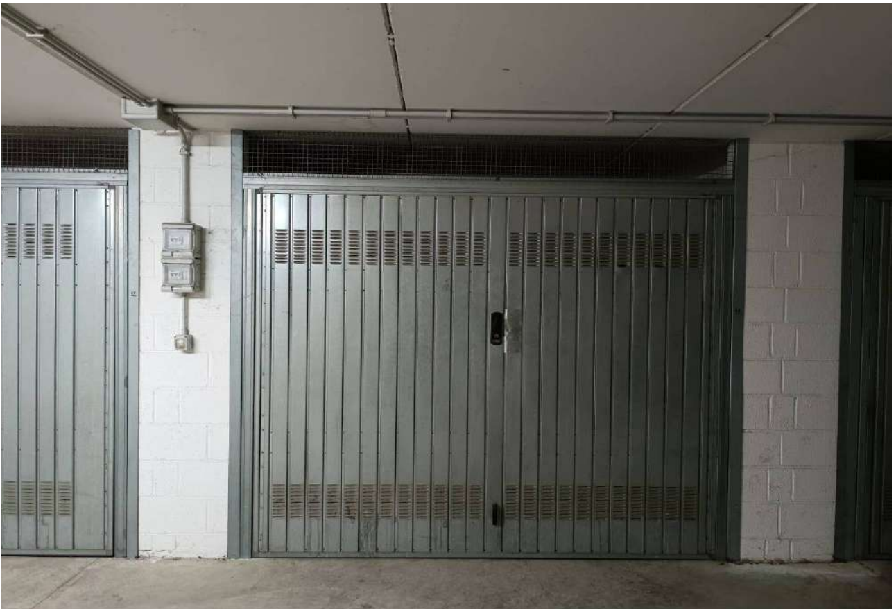
Figg. 33-34 Box Sub. 20 Int. 12 PS1 - Autorimessa interrata: (sopra) spazi di manovra interni; (sotto) porta basculante box Int. 12
