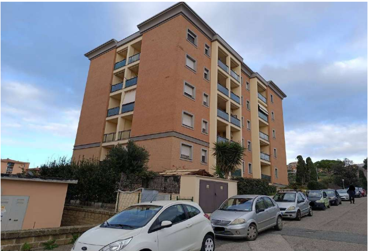
Figg. 1-2 Fabbricato condominiale Via P. Borsellino 3 Tarquinia - (sopra) fronte principale su strada Sud Est; (sotto) fronte laterale Sud Ovest
