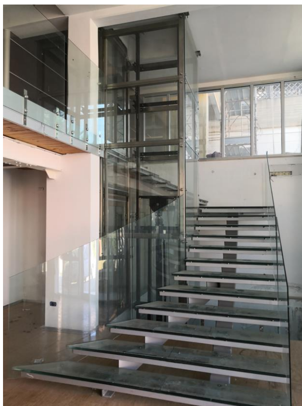
FOTO 4 – ascensore comune ai sub.49-50-53 e scala esclusiva al sub. 53
