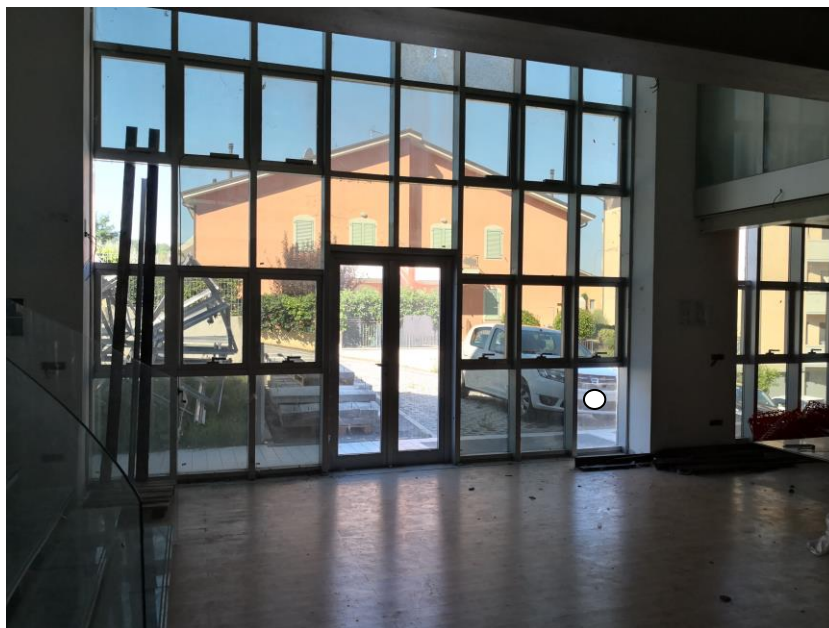
FOTO 3 – ingresso comune ai sub.49-50-53
