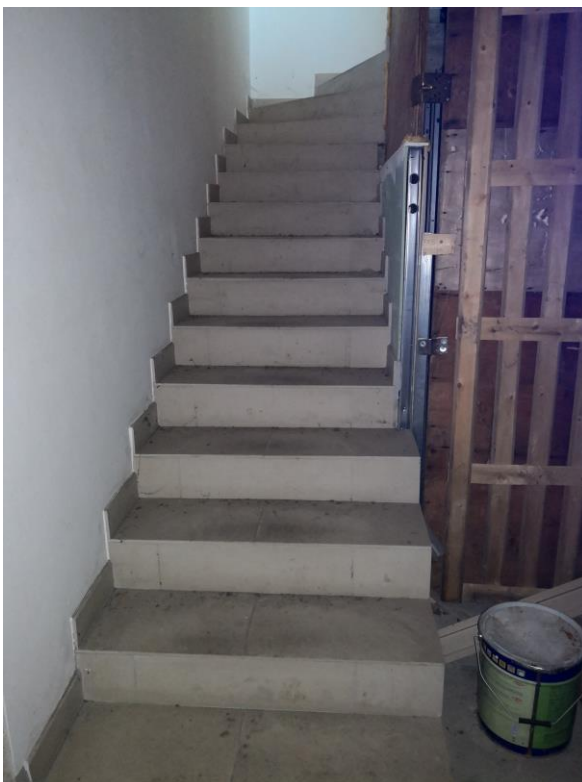
FOTO 13 – scala con adiacente montacarichi comuni ai sub.49-54
