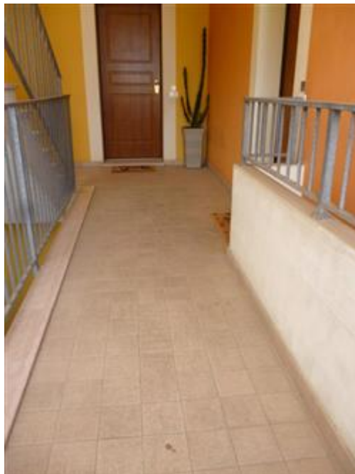
Pianerottolo scala in comune
