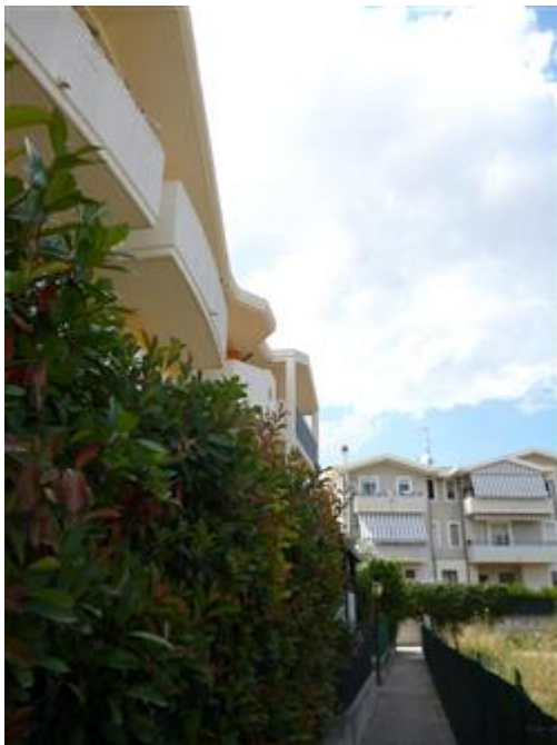
vista retro-prospetto nord-est marciapiede sub. 50
