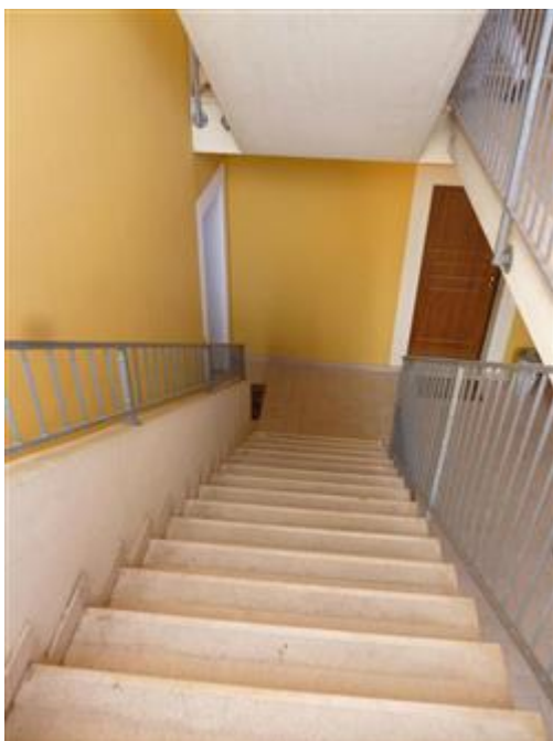
Vista scala esterna di accesso sub. 52
