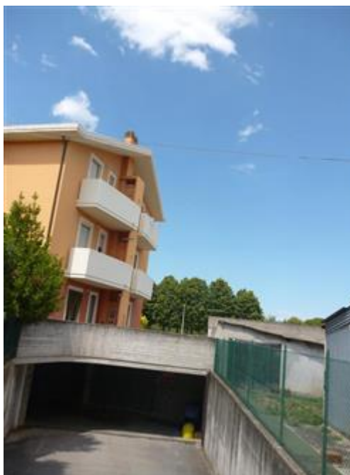
Rampa di accesso alle autorimesse
