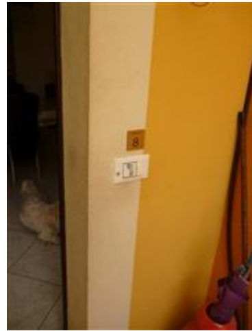
Porta e interno di accesso all'appartamento
