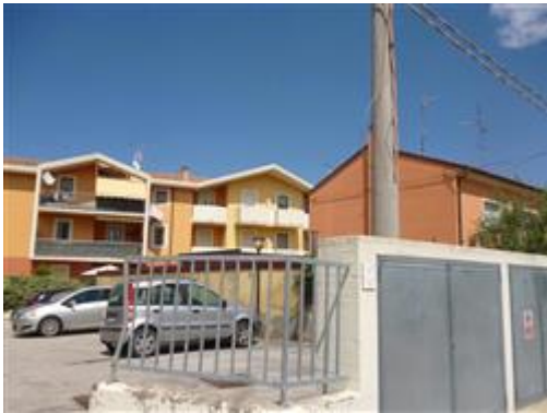
Vista prospetto sud-ovest
