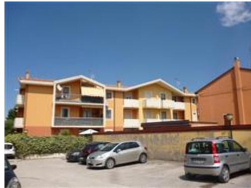
Vista prospetto sud-ovest
