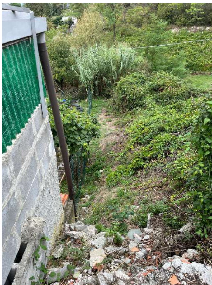
Vista della discesa verso strada del mappale 495
