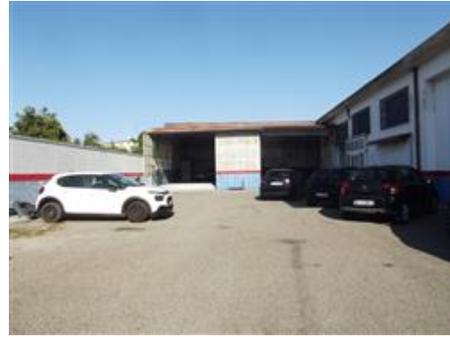
CORTE DI PERTINENZA DEL CAPANNONE
