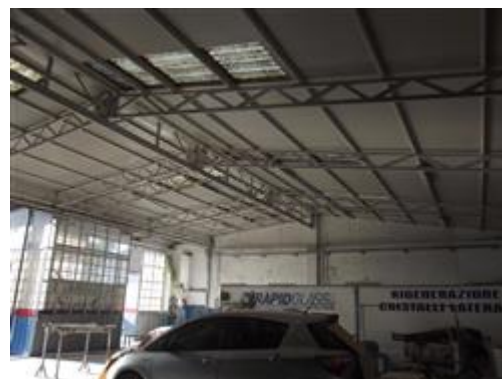
COPERTURA SALA VERNICI E FORNO
