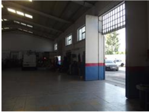
INTERNO DEL CAPANNONE
