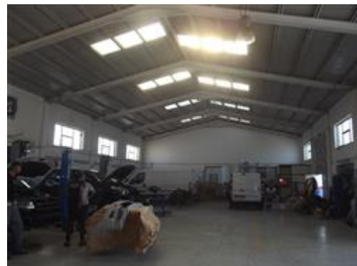
INTERNO DEL CAPANNONE
