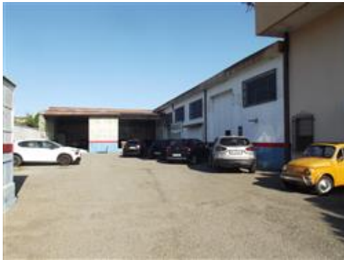
CORTE DI PERTINENZA DEL CAPANNONE
